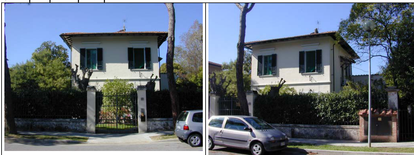
Foto prospetto principale
