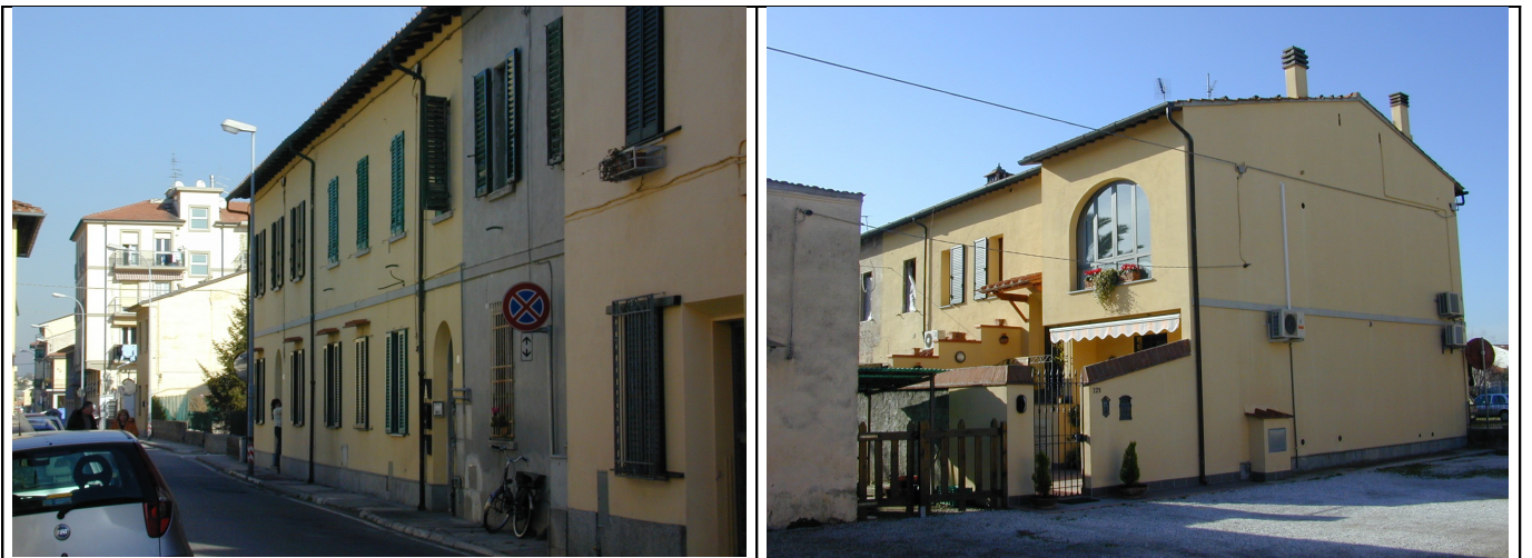
Foto prospetto anteriore e laterale
