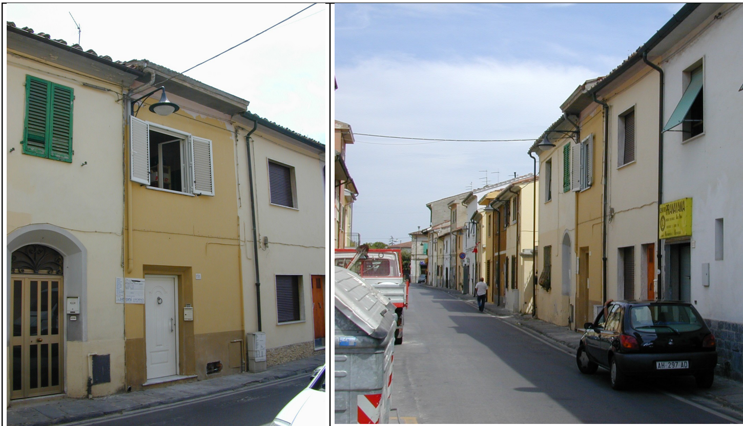
Foto prospetto principale
