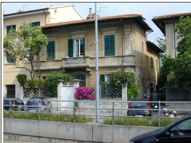
Foto del contesto sul viale delle Cascine
