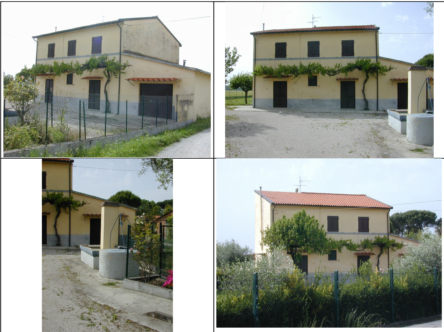
Foto prospetto anteriore e particolare del pozzo con lavatoio
