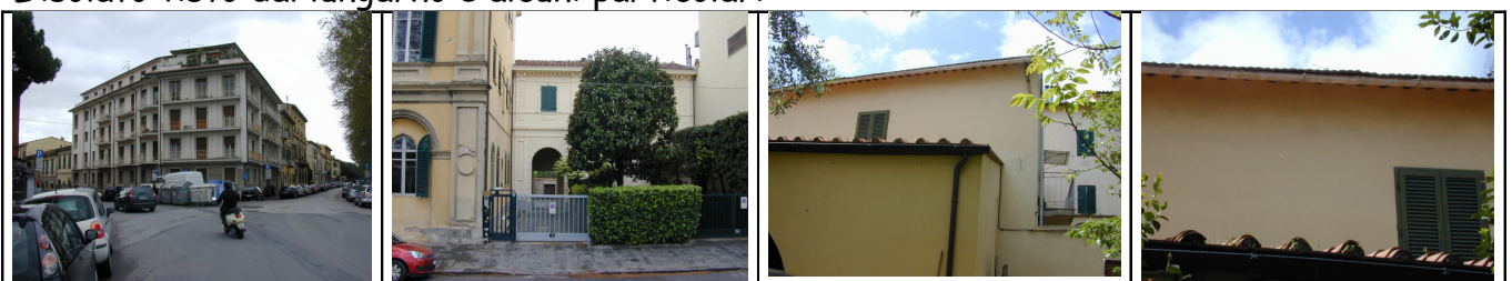
L'isolato visto dal lungarno e alcuni particolari
