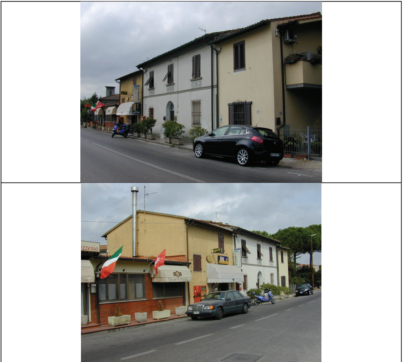
Foto prospetto principale
