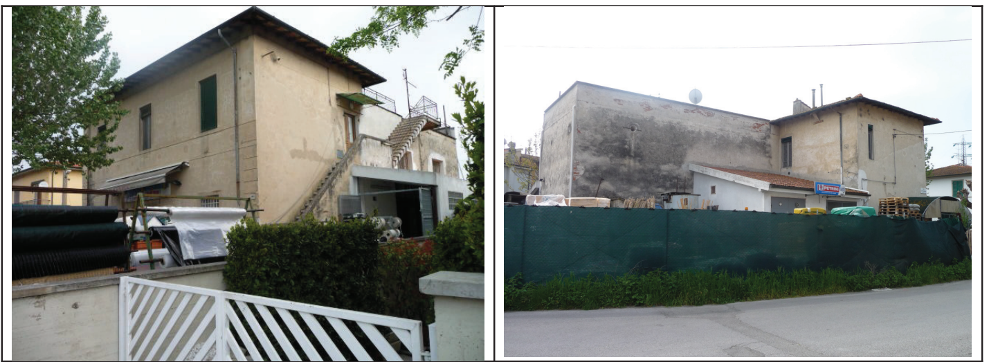
Foto prospetto anteriore e posteriore del complesso edilizio.
