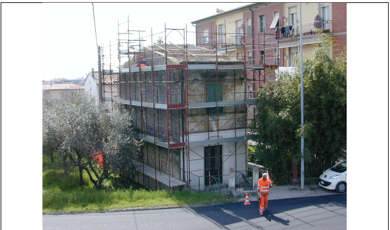
Foto prospetto principale e laterale
