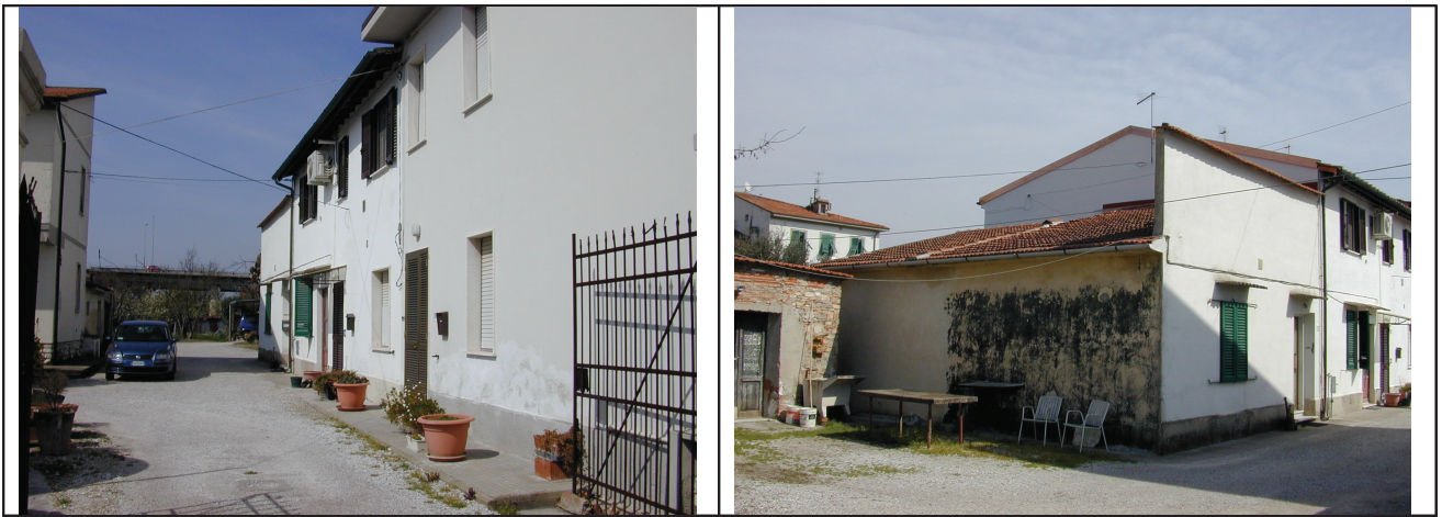
Foto prospetto principale dell'intero edificio e della parte interessata al declassamento.
