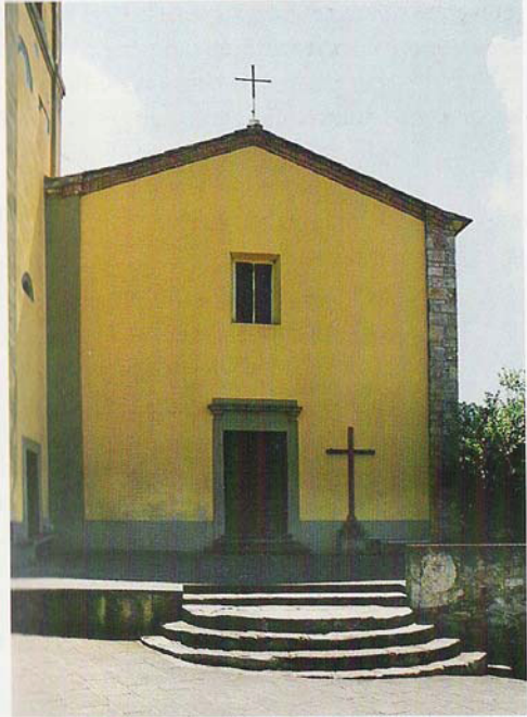
Chiesa di Santa Maria della Neve, esterno, Montemagno.
