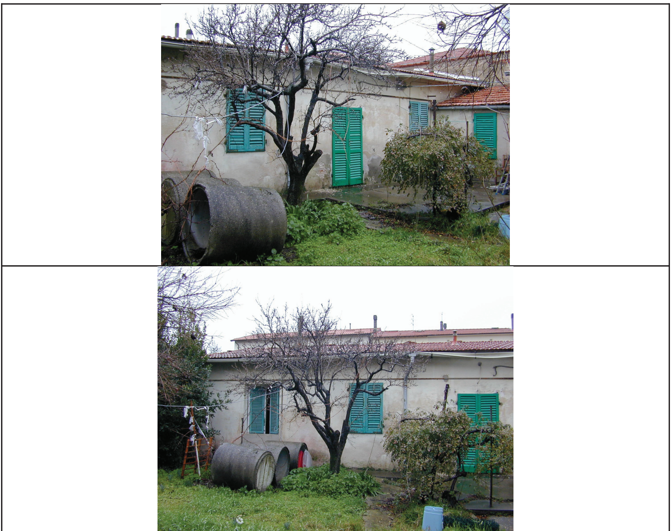
Foto prospetto principale
