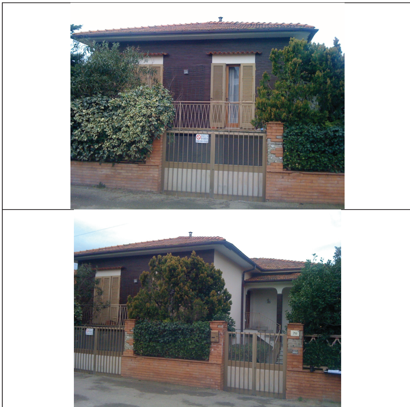
Foto prospetto principale
