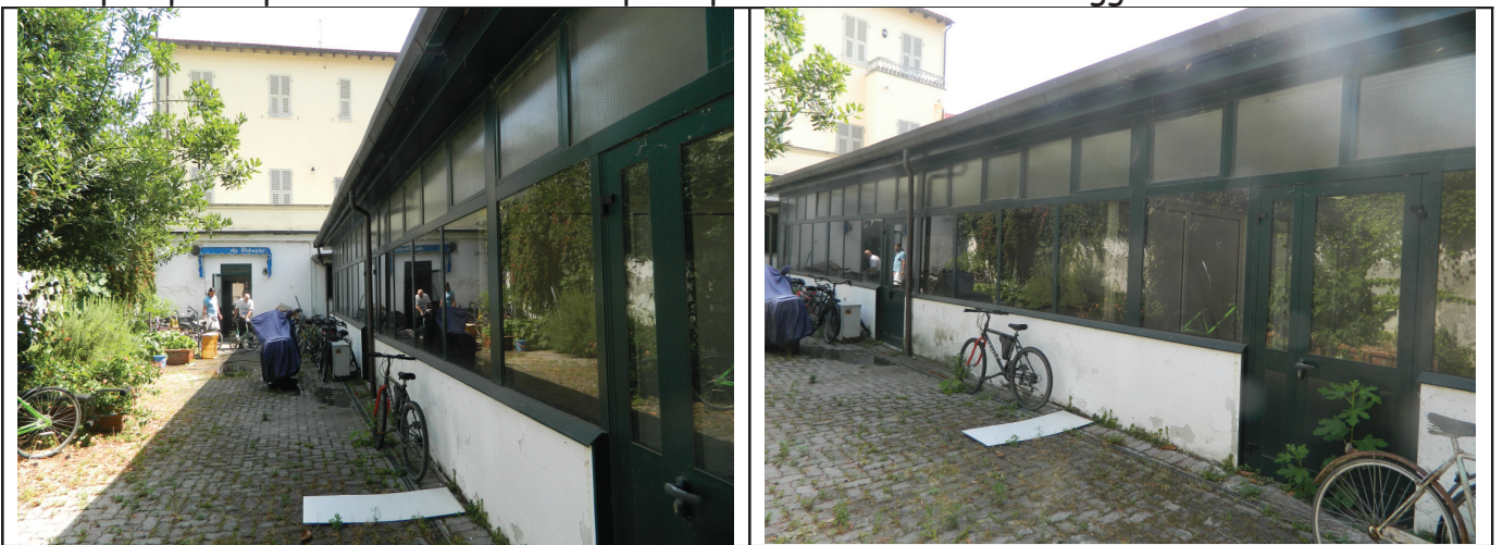
Foto prospetto posteriore dell'edificio principale e del manufatto in oggetto
