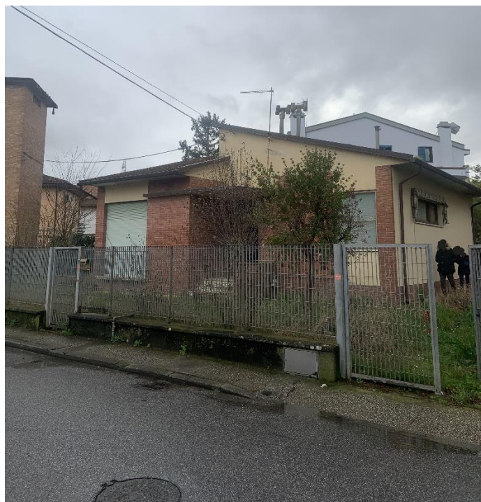
Prospetto principale da via dei Piastroni
