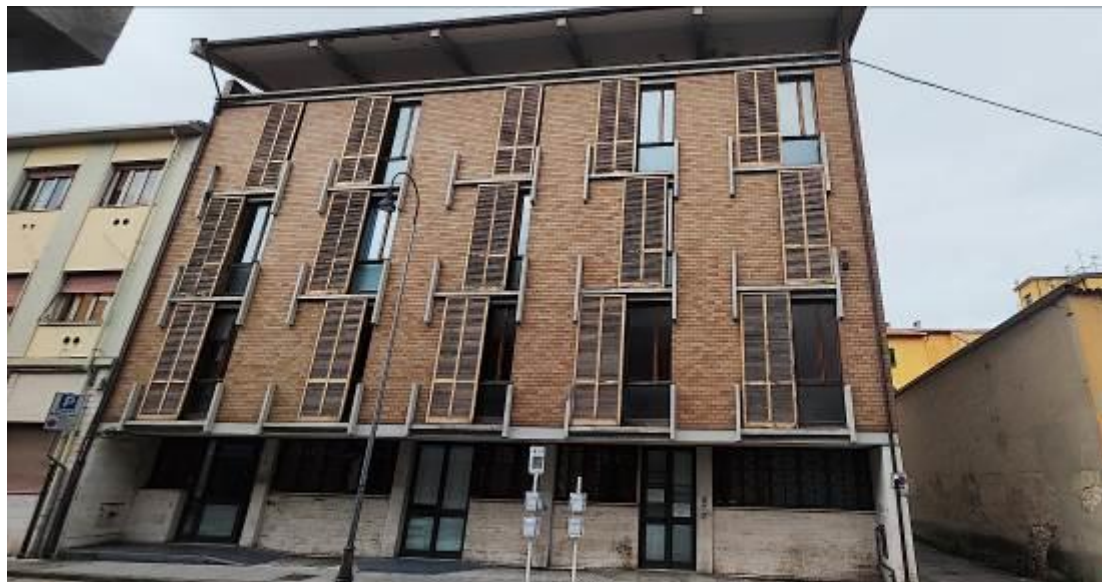
Facciata principale su Via E. Fermi
