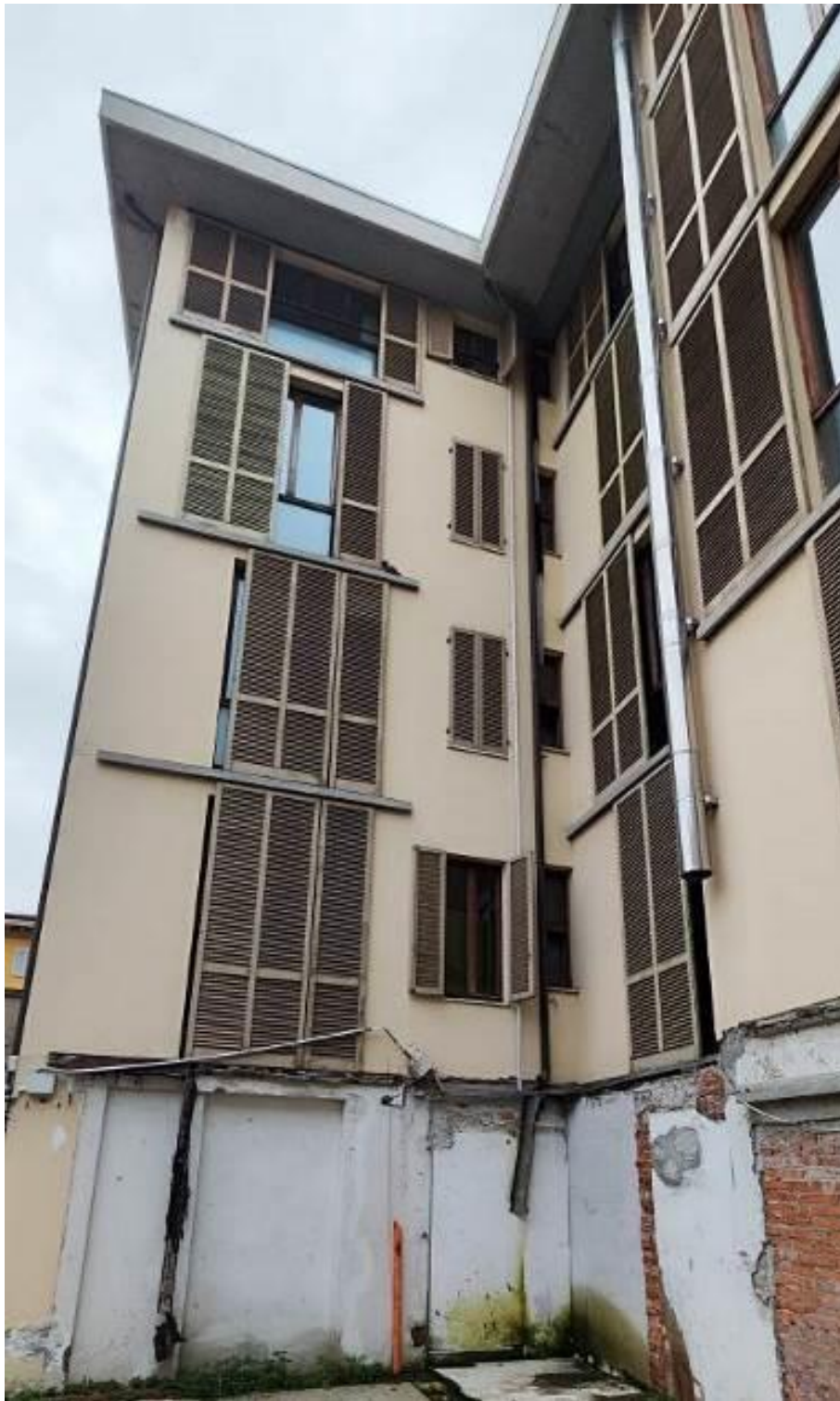
Facciata sul cortile interno – particolare locali tecnici demoliti
