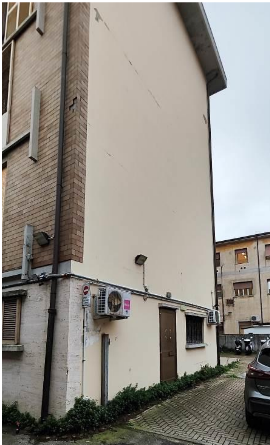
Facciata su cortile interno
