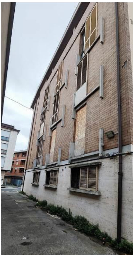
Facciata laterale sul passo carrabile
