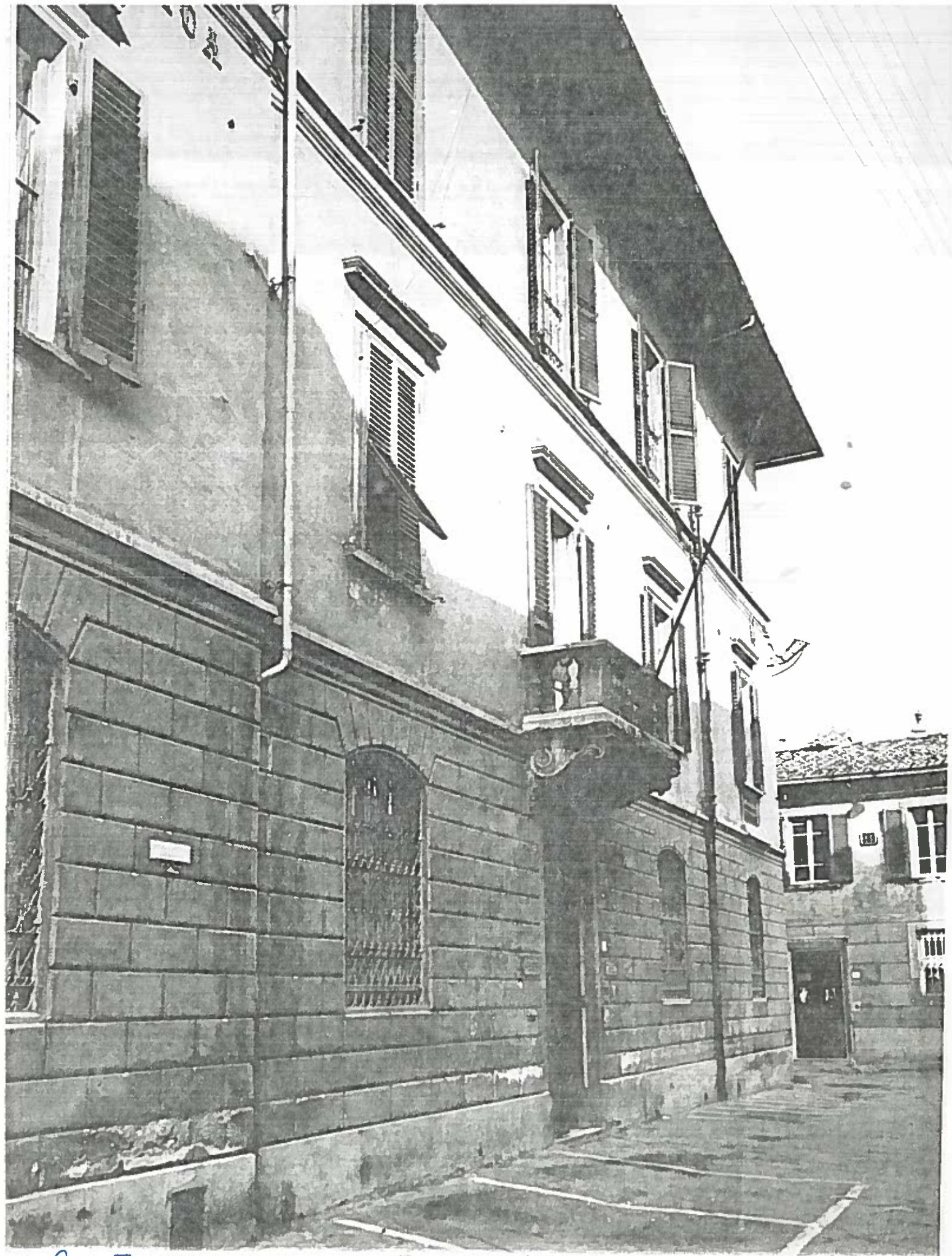
P. via Torricelli 2 | SOWATO 60 174/4 NEGATIVO 18861
