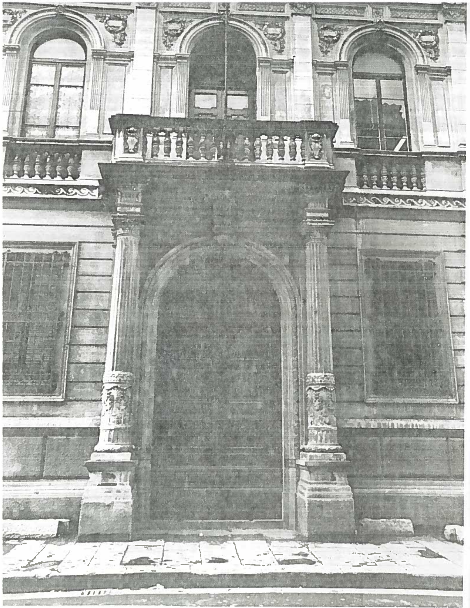
VIA CRISTOFORO E MONTANARA SAPIENZA ISOLATO 186/1 NEGATIVO 19230
