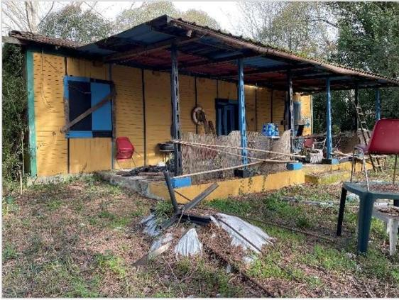
*Figura 1 Edificio legno misto muratura non agibile (da demolire)*
