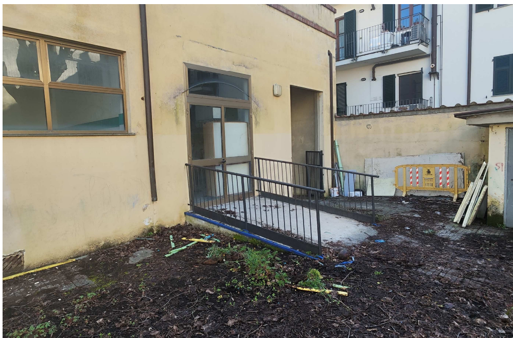
Realizzazione di rampa inclinata
