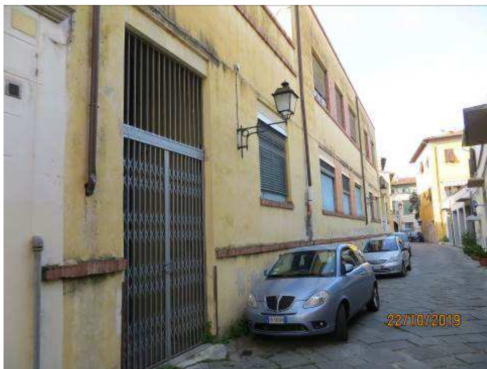
Trasformazione di finestra in accesso carrabile su via Coccapani
