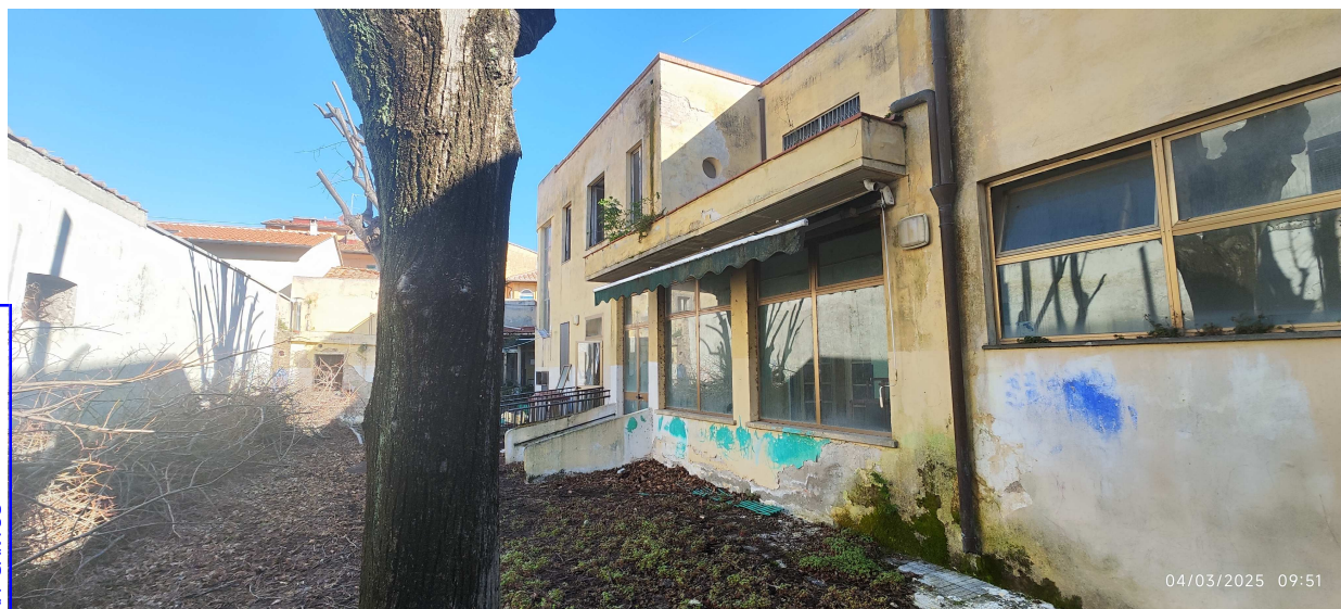
Chiusura portico per ricavare un'aula a servizio dell'asilo – Delibera G.C. n. 4843 del 04/11/1981
