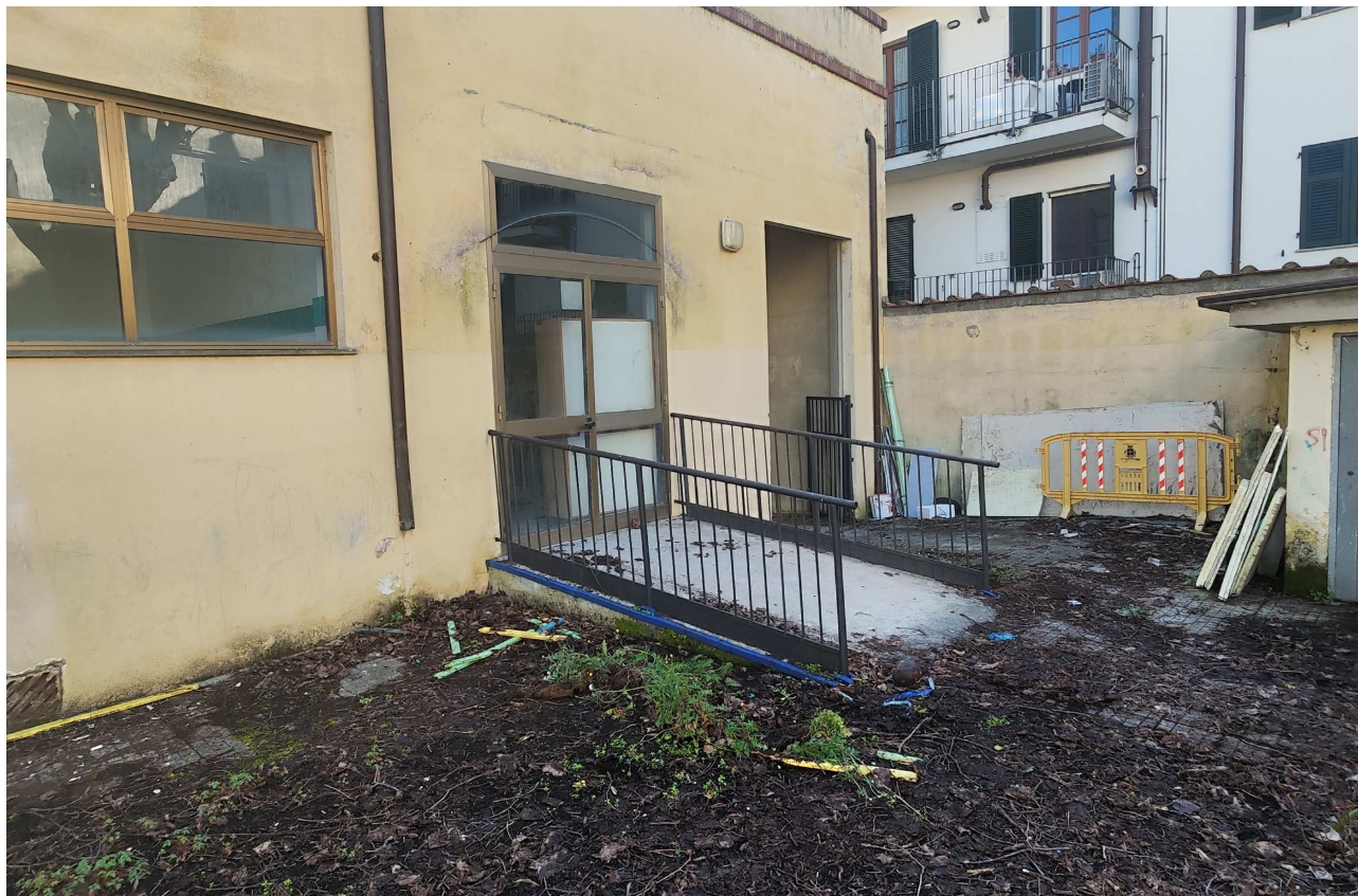
Realizzazione rampa inclinata
