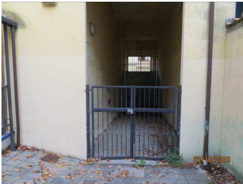
Finestra trasformata in accesso carrabile – vista interna dal giardino
