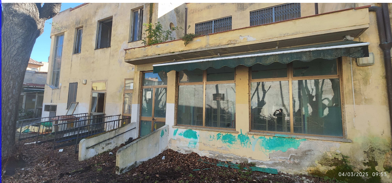
Chiusura portico e realizzazione di aula per l'asilo
