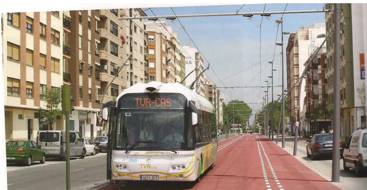
Fig. 10 - Esempio di palo su un solo lato con mensola a sbalzo da 8 metri. Castellon de la Plana (Spagna)
