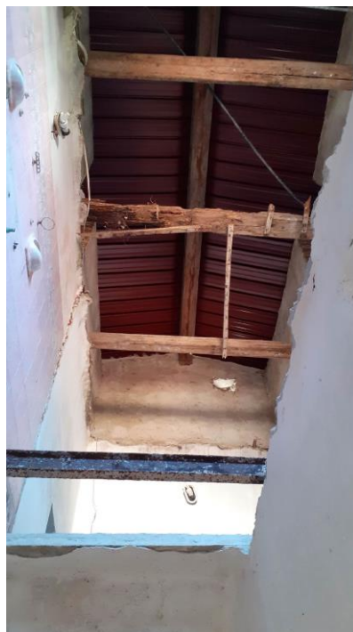
vista del colmo della copertura prima e dopo i lavori di messa in sicurezza
