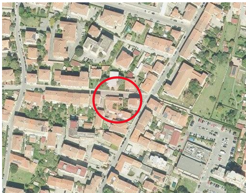
Foto aerea del 07/09/2023 in cui si notano le due falde di copertura crollate (fonte: www502.regione.toscana.it/geoscopio )
