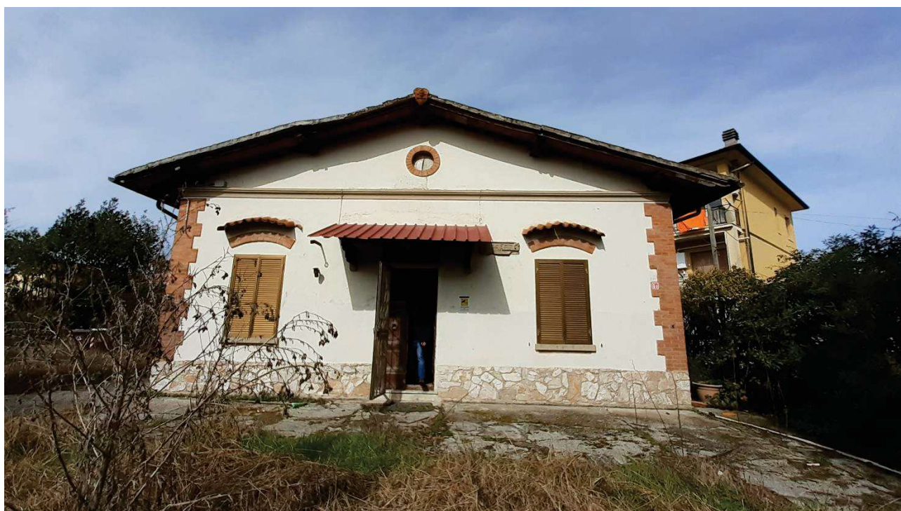
- Prospetto principale edificio -
