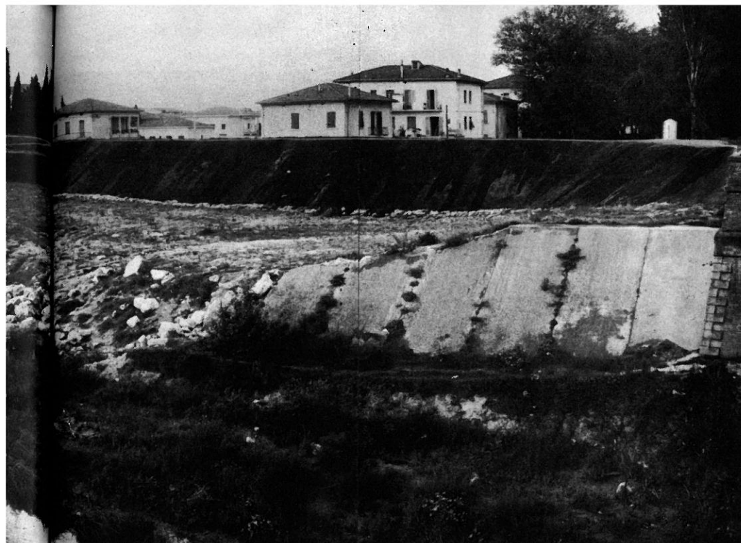
— 114 — Lavori di ripristino della scarpata di rivestimento della riva sinistra dell'Era, subito a monte di Pontedera.
