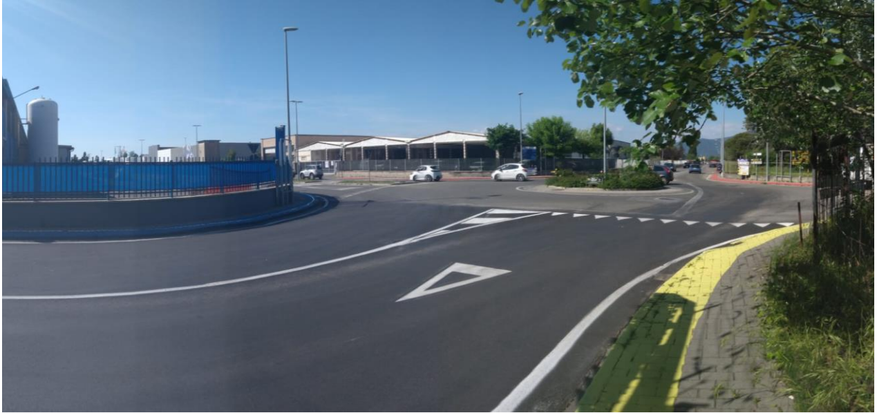
Figura 3.8.7 - Segnaletica orizzontale in zona Ospedaletto
