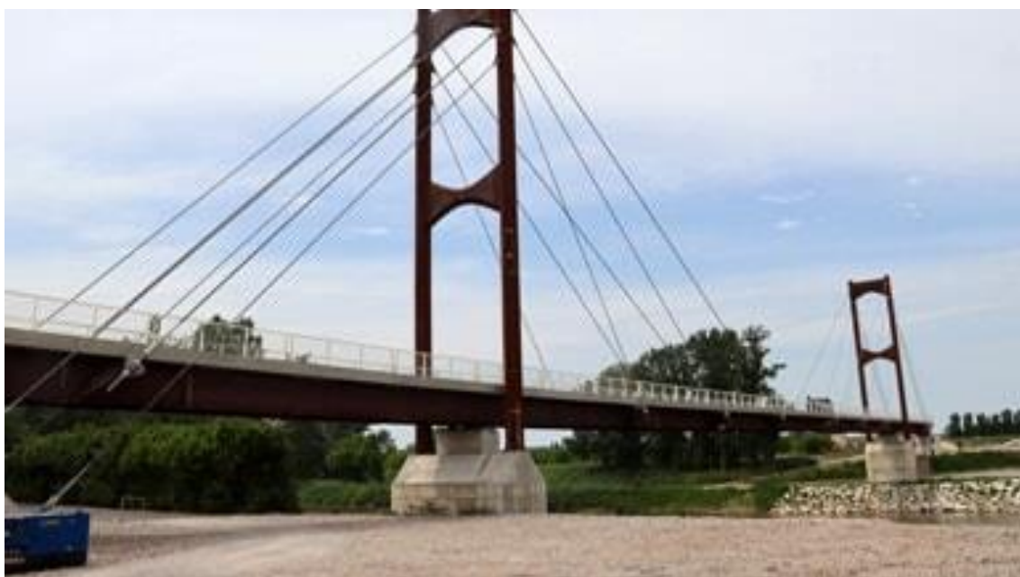
Figura 3.4.12 – Il nuovo ponte ‘strallato’ che collega Rigione a Cisanello
