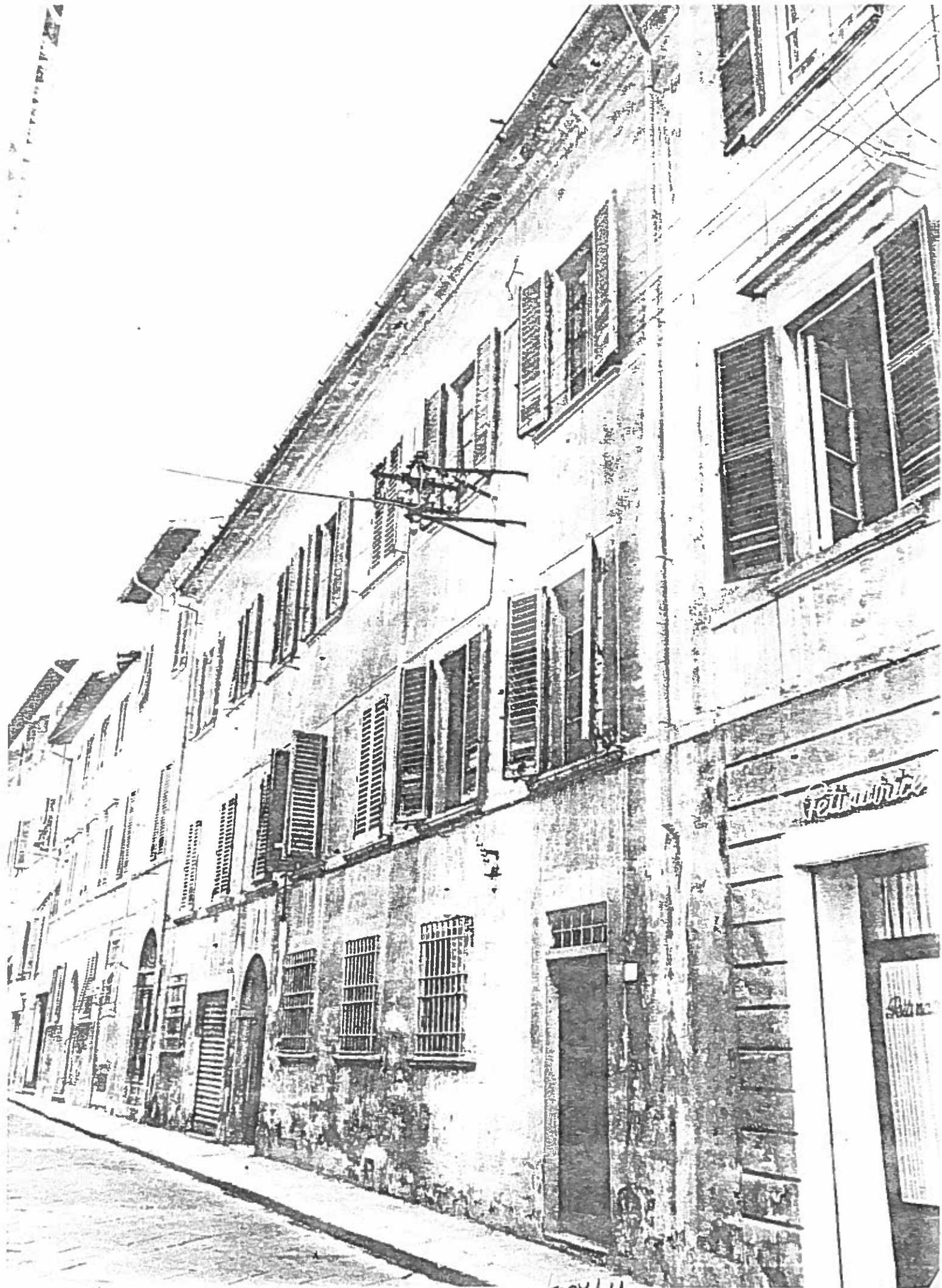
VIA FUCINI DAL 42 AL 48 ISOLATO 197 11 NEGATIVO 18036
