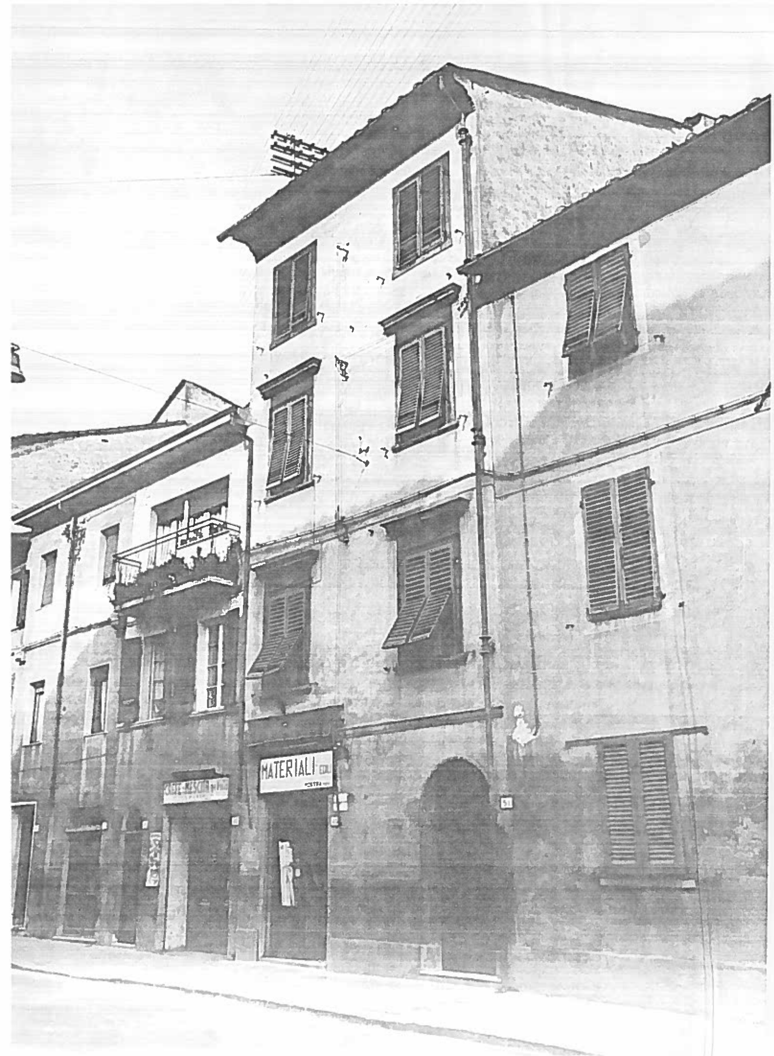
VIA GARIBANDI DAL 43 AL 51 ISOLATO 96 NEGATIVO 18939
