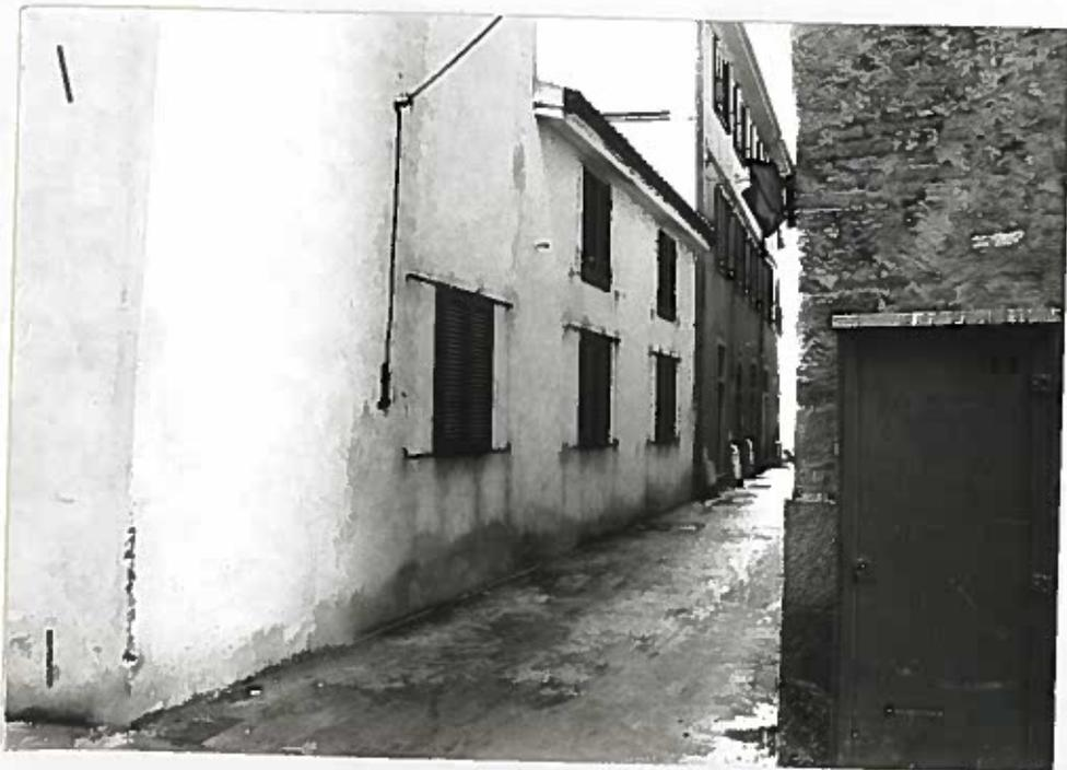
Via del Cuore: ad angolo con via delle Belle Torri, costruzione diroccata: a pt. cantoni di verrucano; a metà piano traccia di muro continuo a conci della stessa pietra e traccia di portale con architrave, e pilastro. Al 1° p. muro in mattoni in cui verso l'angolo si doveva aprire una monofora con arco in cotto a tutto sesto, frammentario.
