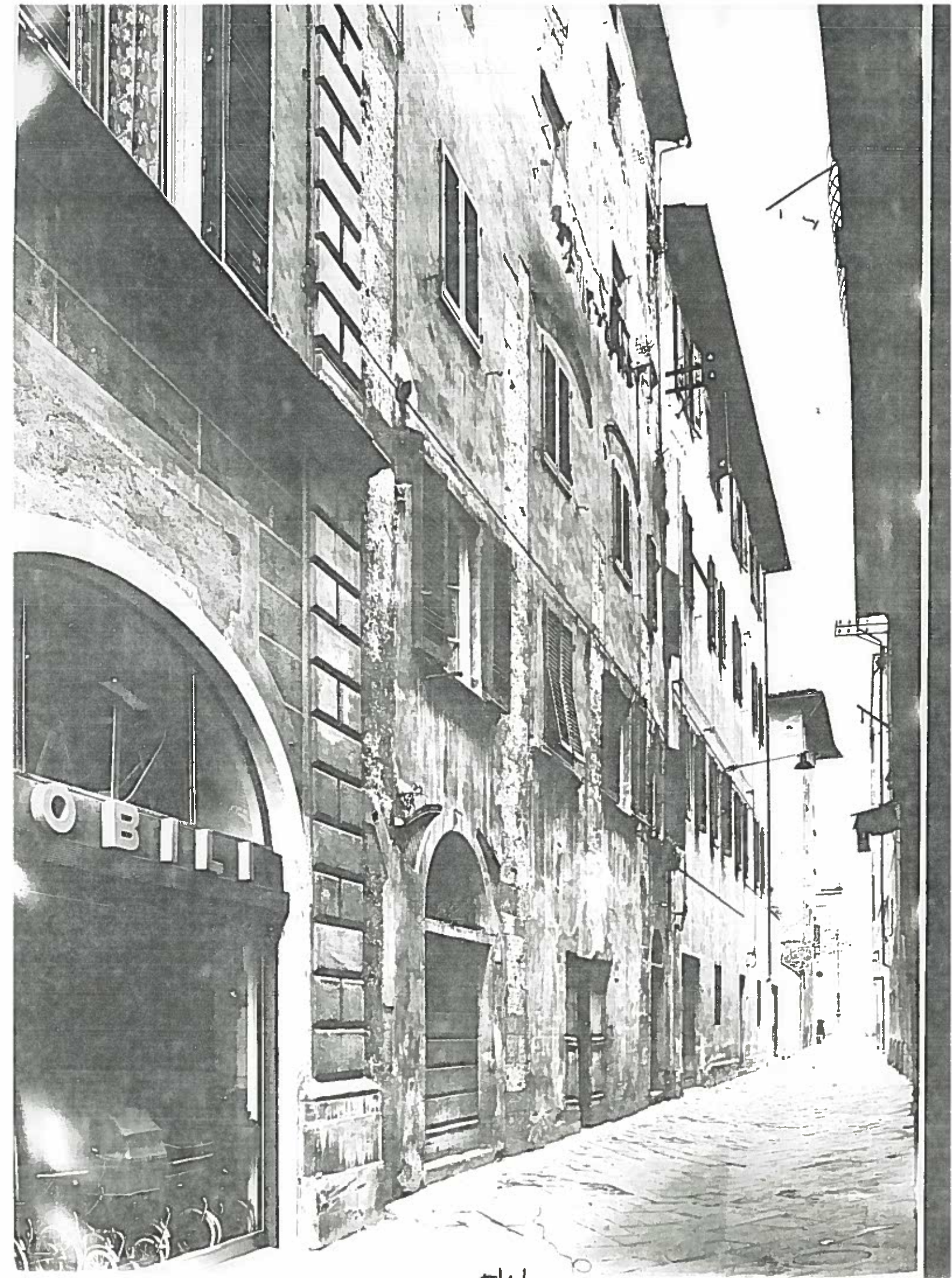
VIA MOSCONI no 12.10.8 ISOLATO 54/3 NEG. 13816
