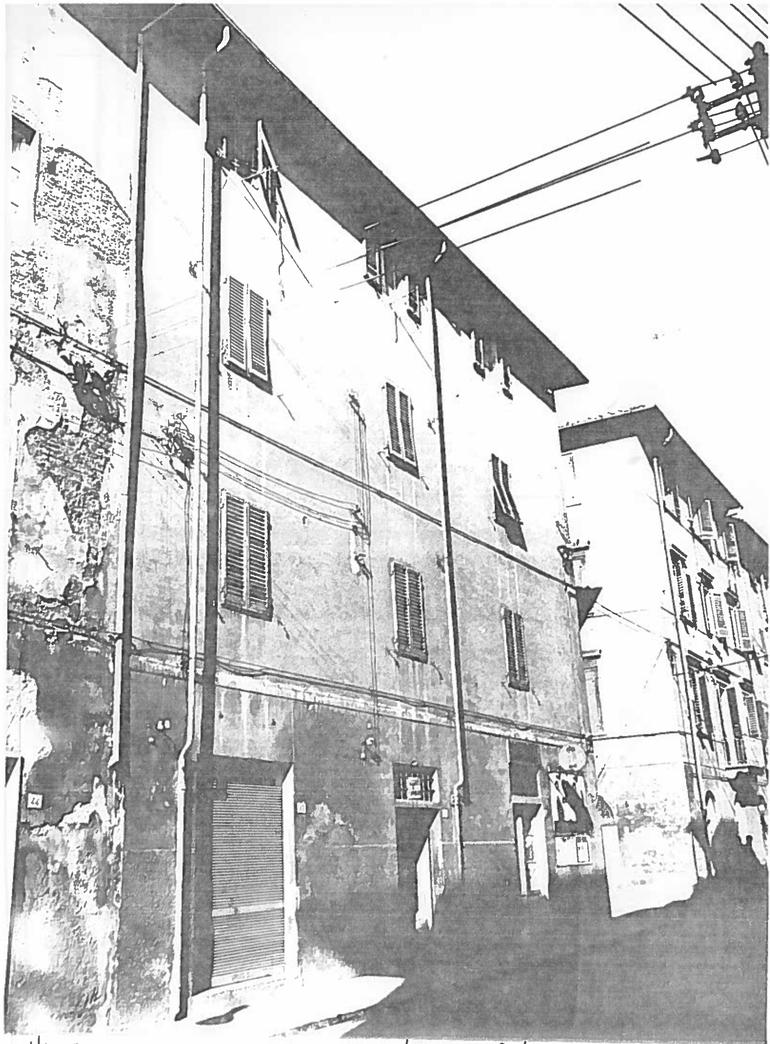
VIA S. ANTONIO DAL 38 AL 42 / SOLATO 31/8 NEGATIVO 20054
