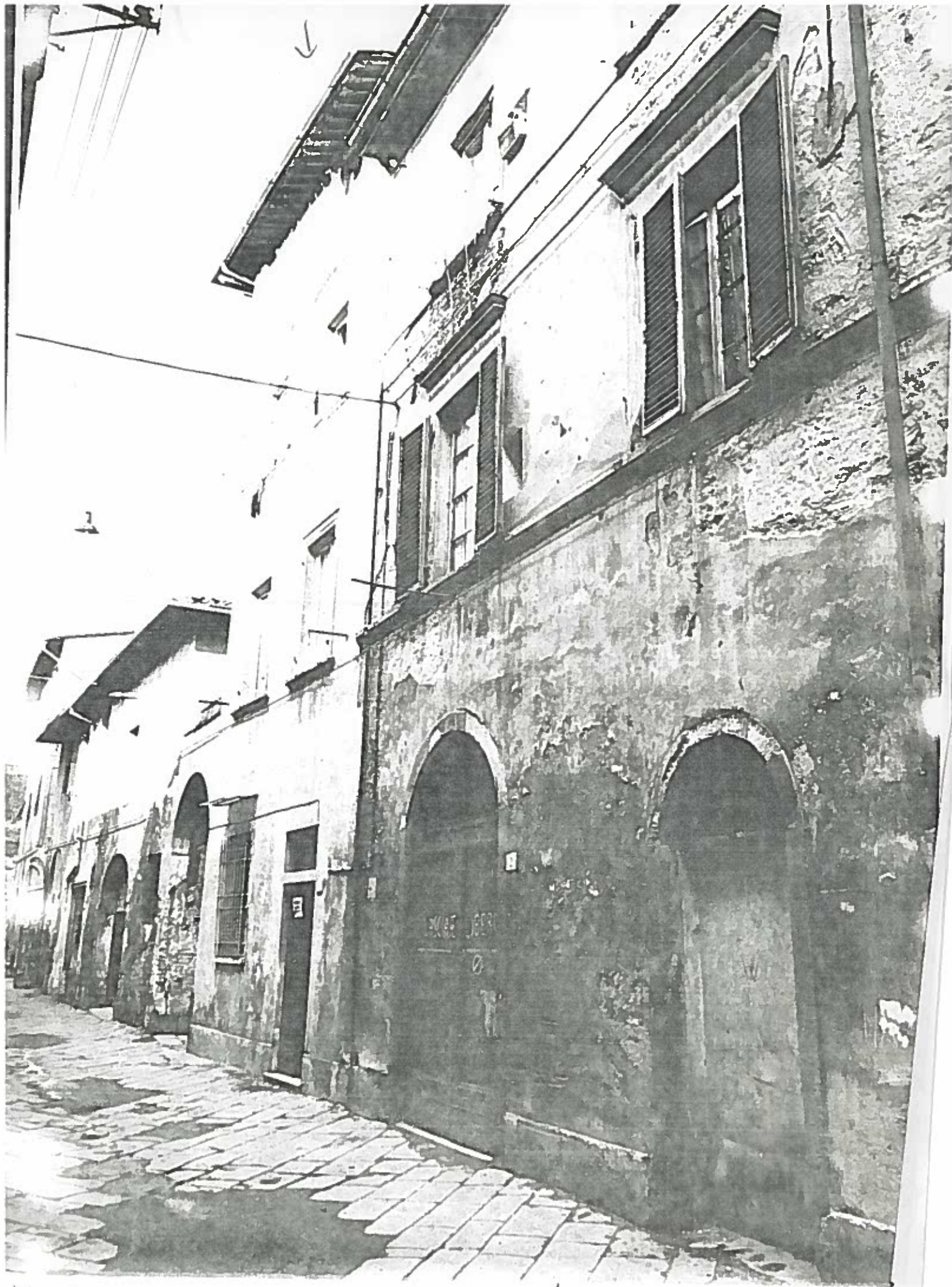
VIA S BERNARDO n° 2 4 6 ISOLATO 25/5 NEG. 17870
