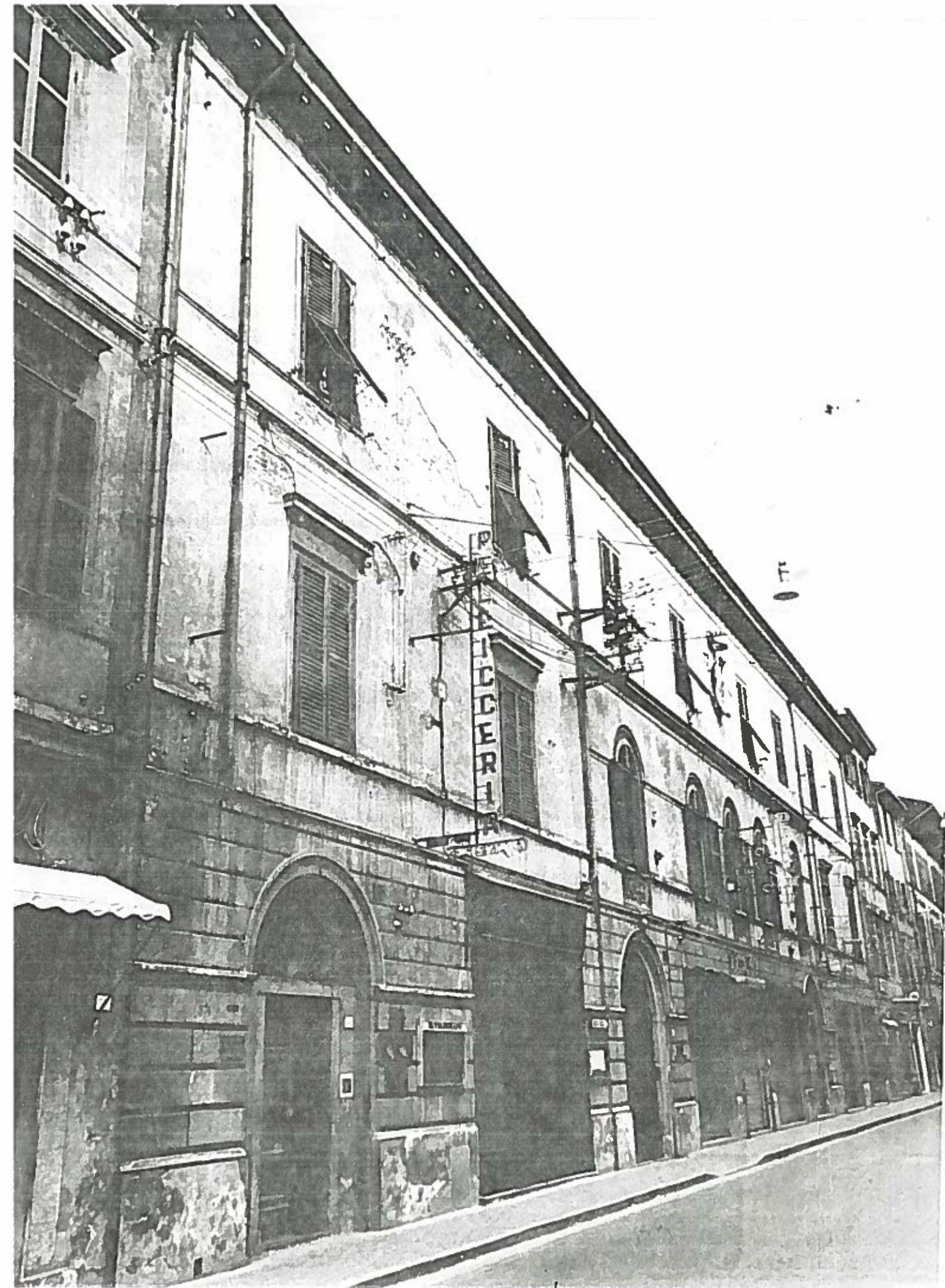
CORSO ITALIA dal 76 al 90 ISOLATO 2915 Negativo 20248
