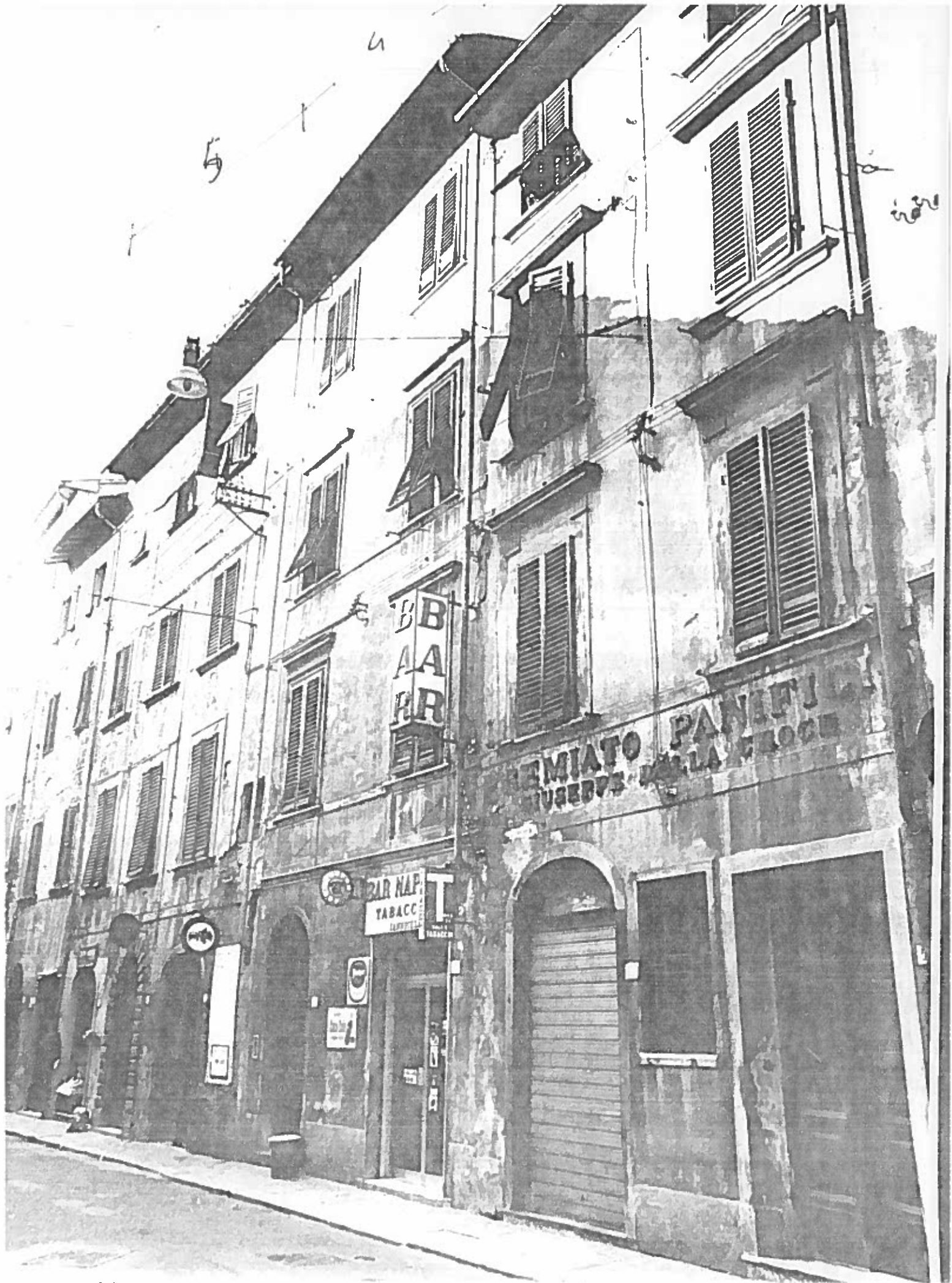
VIA MAZZINI DAL 58 AL 68 ISOLATO 29/4 NEGATIVO 20184
