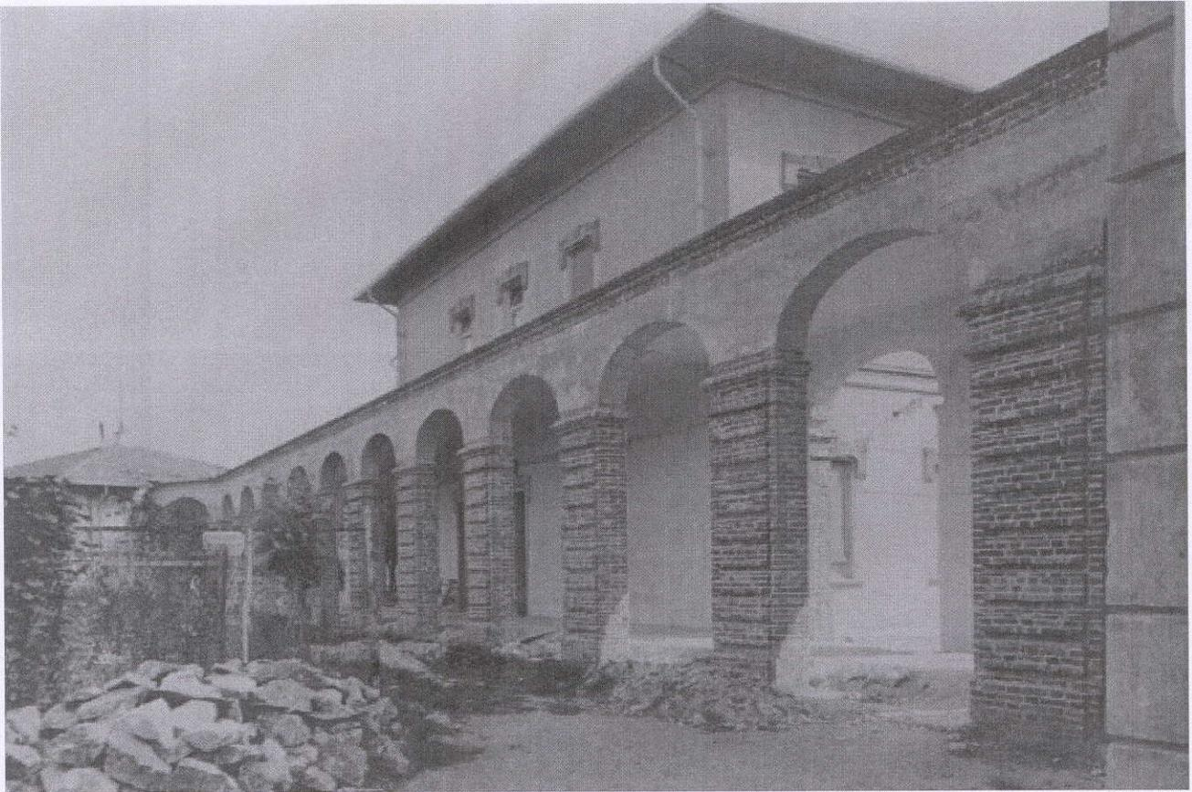
Fig. 15. Vista del porticato del Tubercolario. Intervento successivo di sostituzione delle colonne metalliche .
