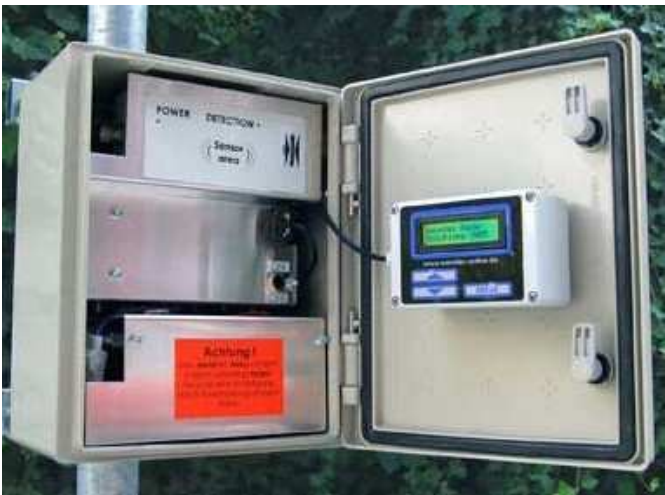
Figura 3.1 – Strumentazione radar Wavetech
