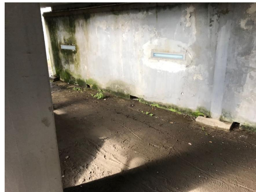
Figura 7. Fotografia delle caditoie a bocca di lupo che collettano le acque dalle zone esterne fino alla rete ad anello.
