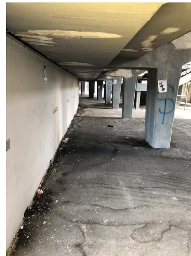
Figura 8. Fotografia dell'area sotto le tribune. L'acque scorre dalle aree esterne verso le tribune e viene raccolta da un sistema di caditoie poste lungo la parete.
