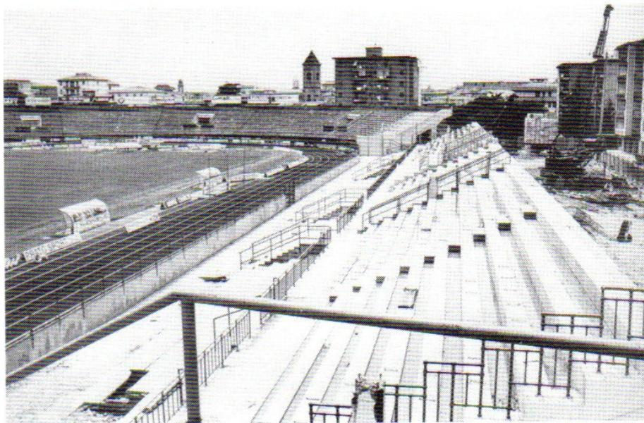
**Figura 4.27 – Demolizione copertura vecchia tribuna (Luglio 1982)**
