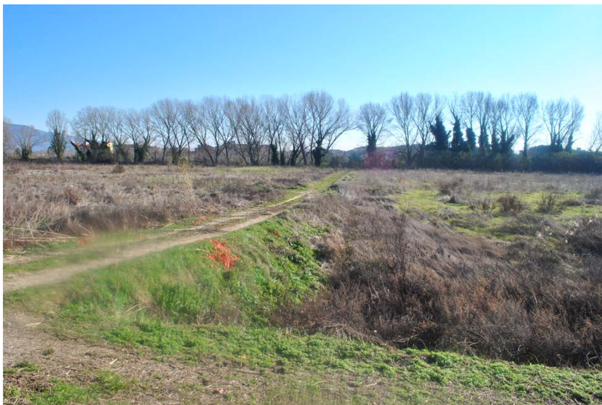
Fig.9 -10 Accesso al ponte da Cisanello
