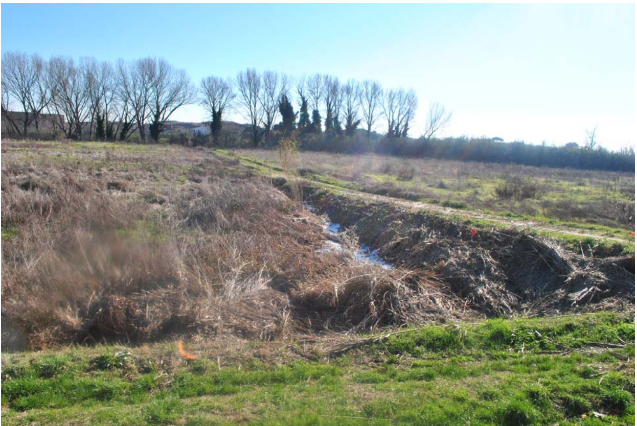
Fig.11 -12 Accesso al ponte da Cisanello
