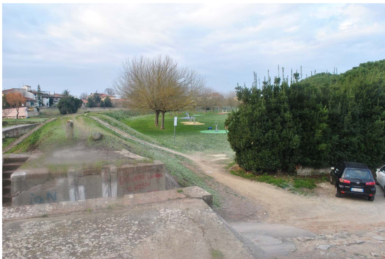
Fig.3 Accesso al Ponte a Riglione
