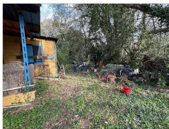
Figura 4 Edifici in legno crollati
