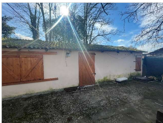
Figura 1 Manufatto da demolire
