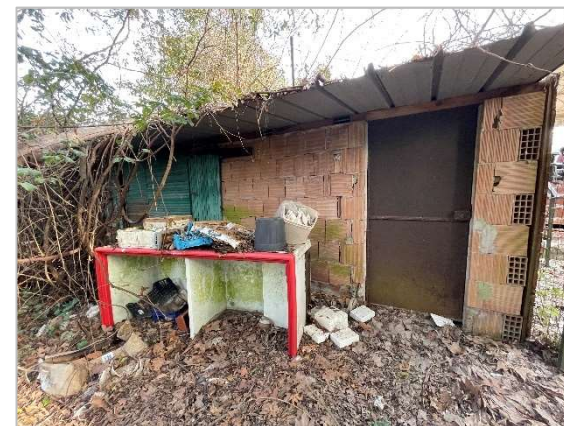
Figura 6 Magazzino in muratura da demolire
