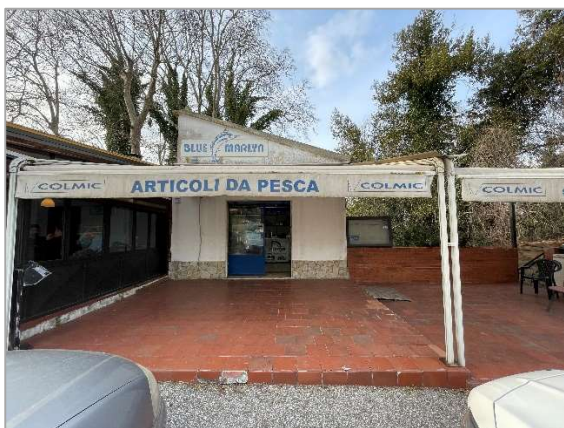
Figura 1 Ingresso negozio (F.51, part.34 sub.2)
