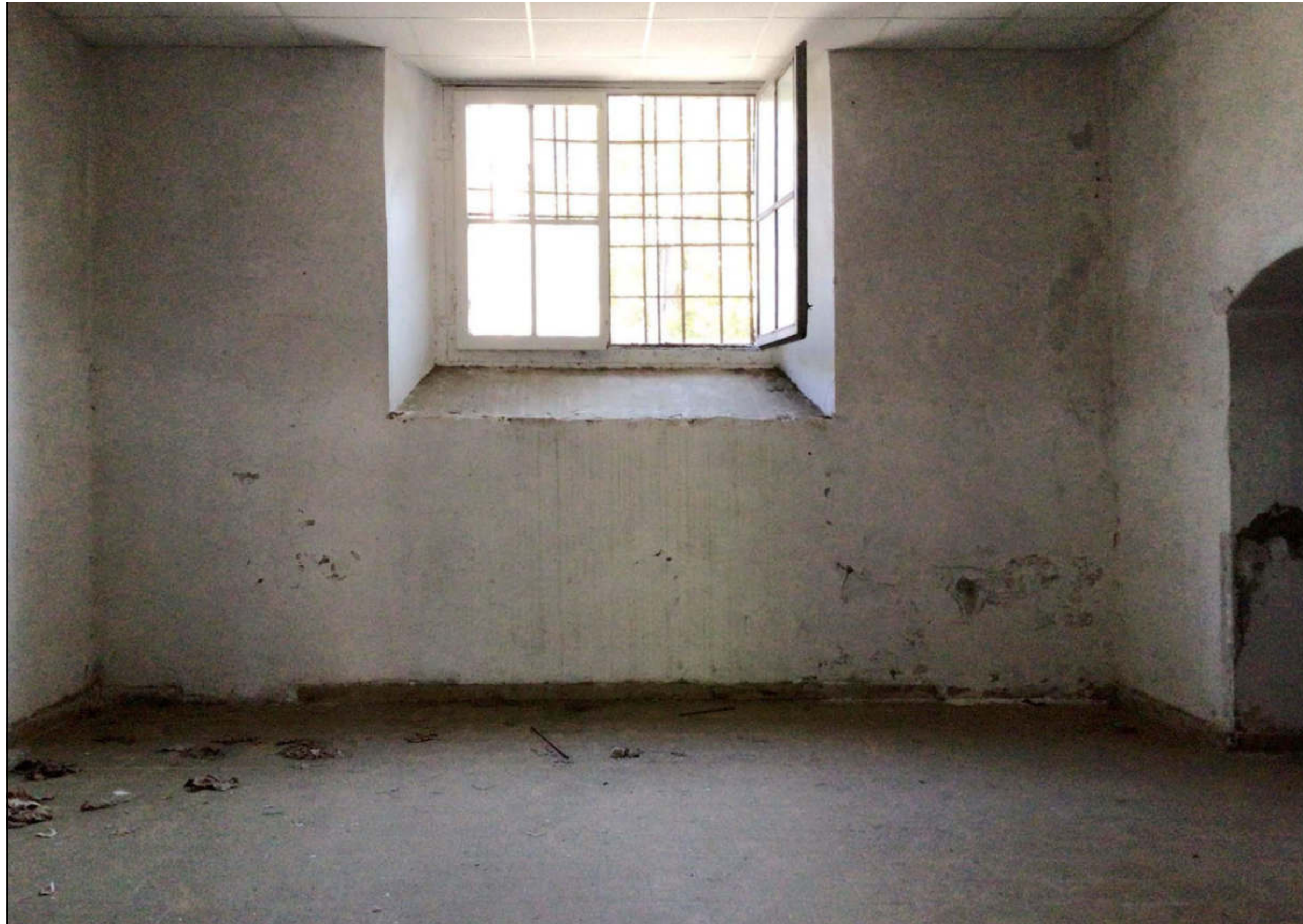
↑ Foto 14_Locale piano terra
