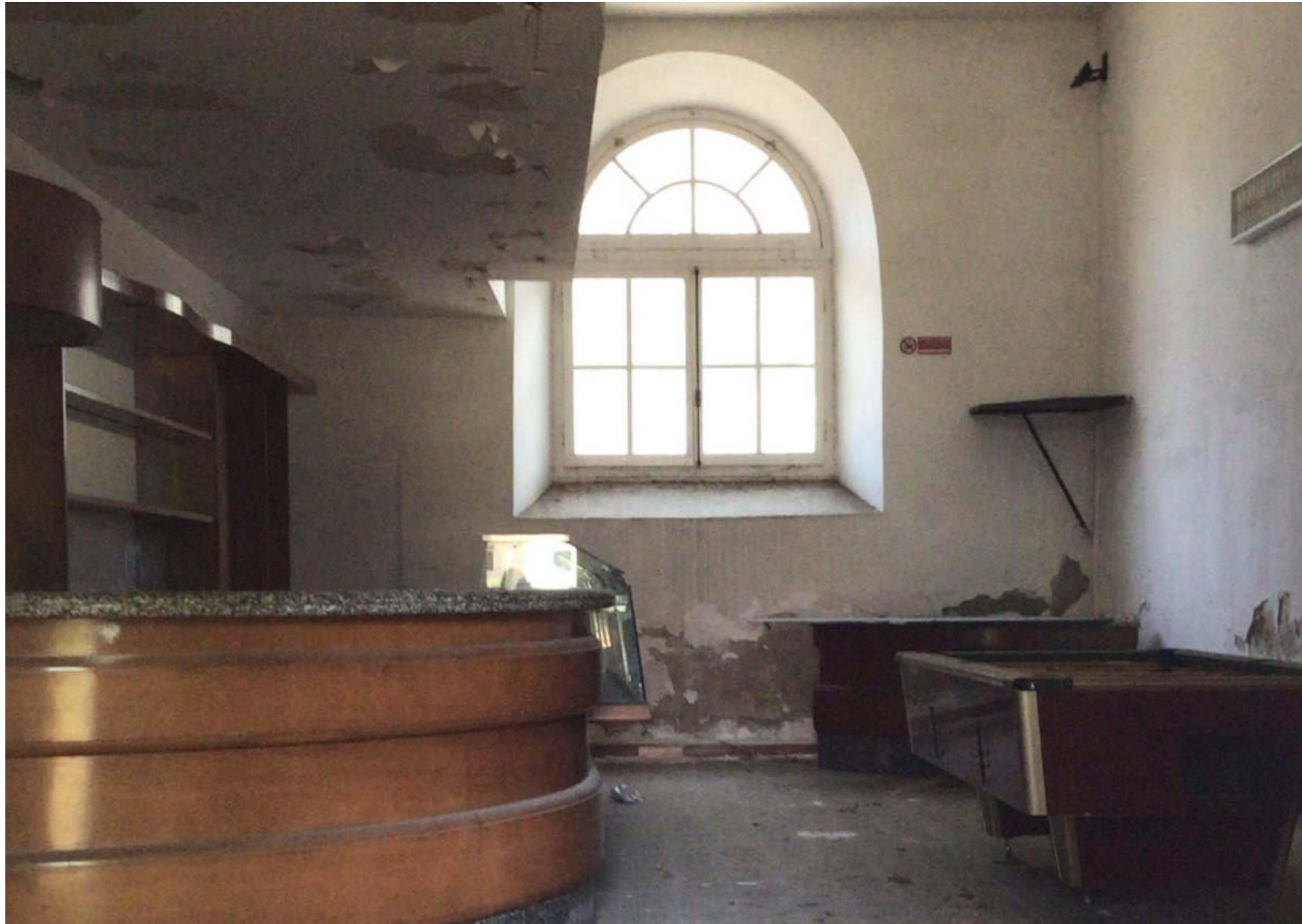
↑ Foto 13_ Locale piano terra
