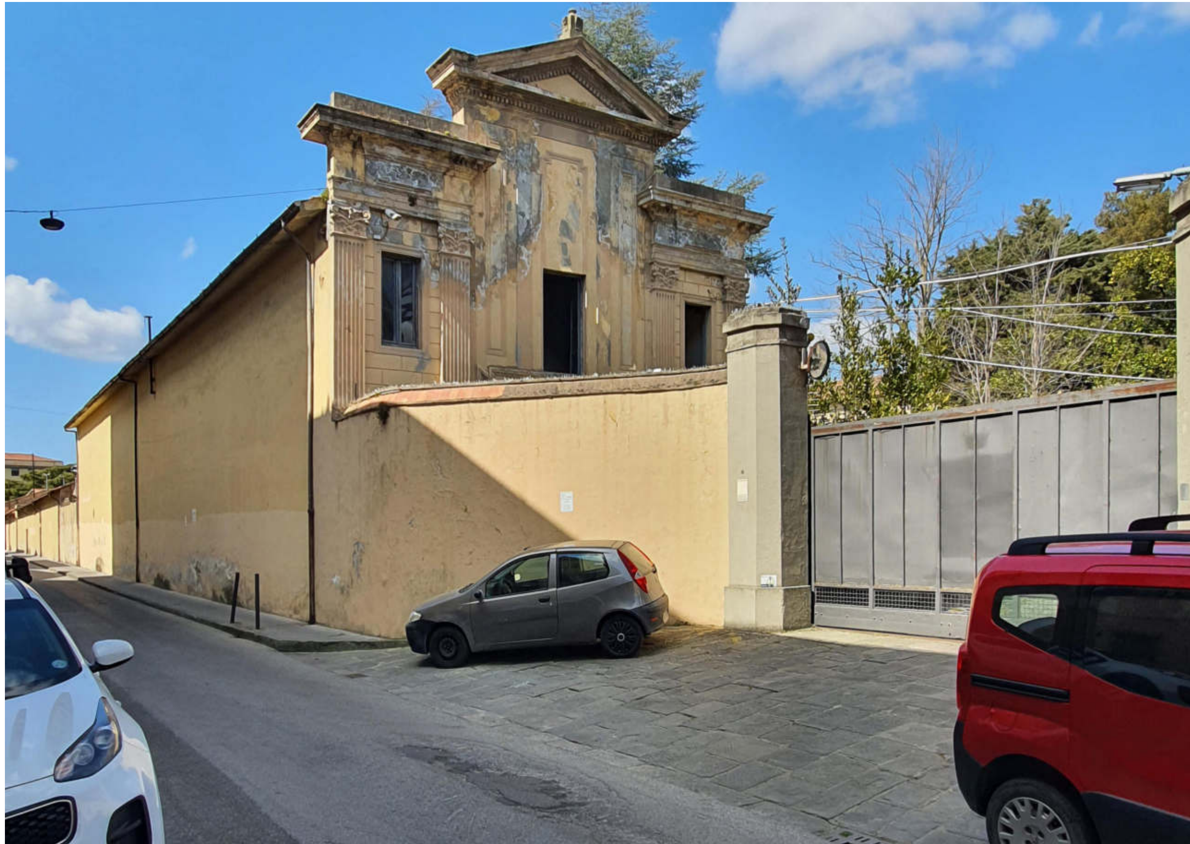
↑ Foto 5_Ingresso Via Derna
