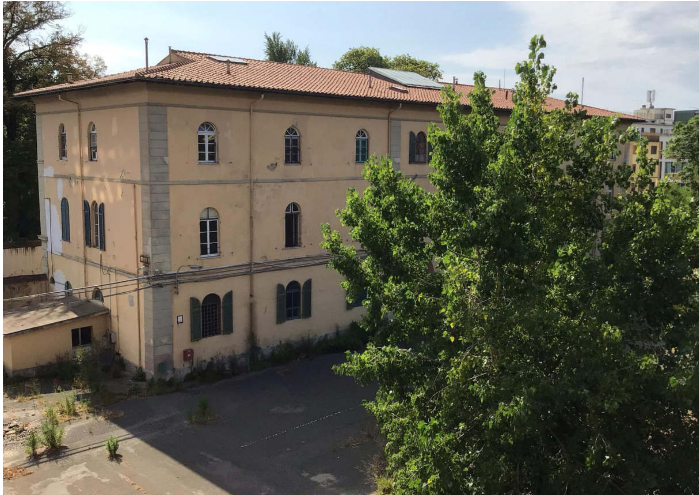
↑ Foto 12_Palazzina Ufficiali
