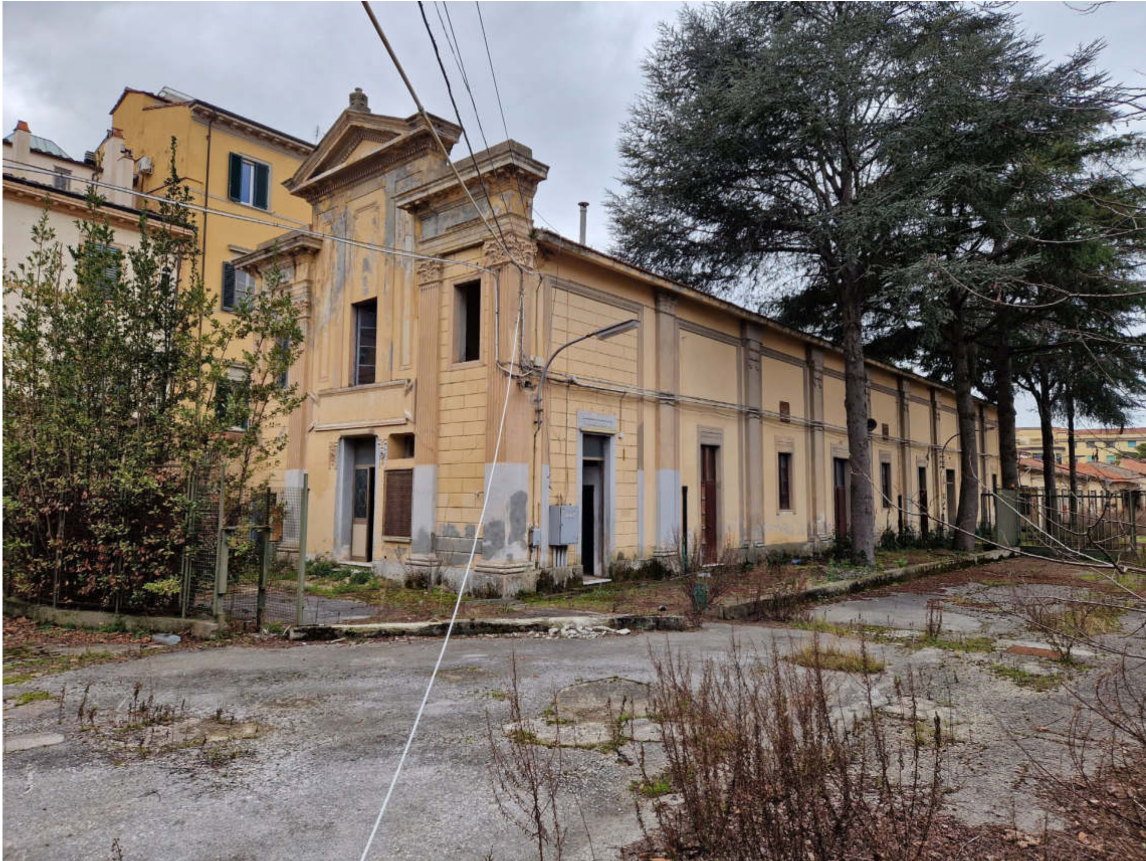
↑ Foto 17_Vista esterna teatro
