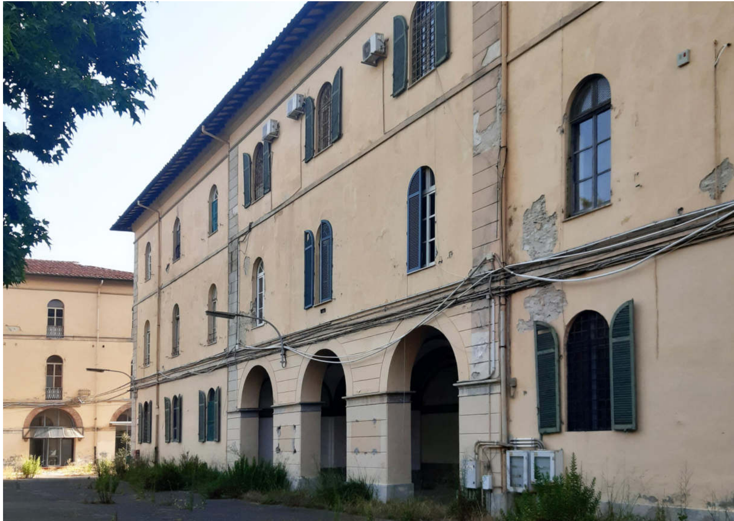
↑ Foto 9_Loggia ingresso Palazzina Ufficiali
