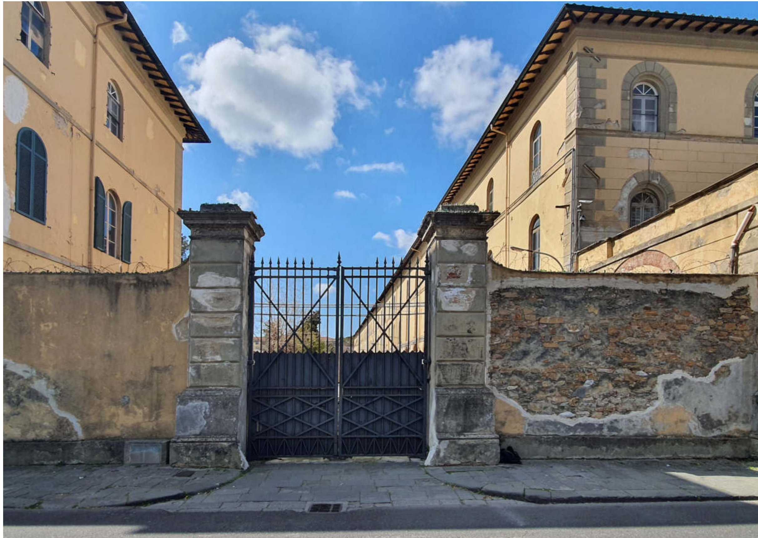
↑ Foto 6_Ingresso su Via Roma
