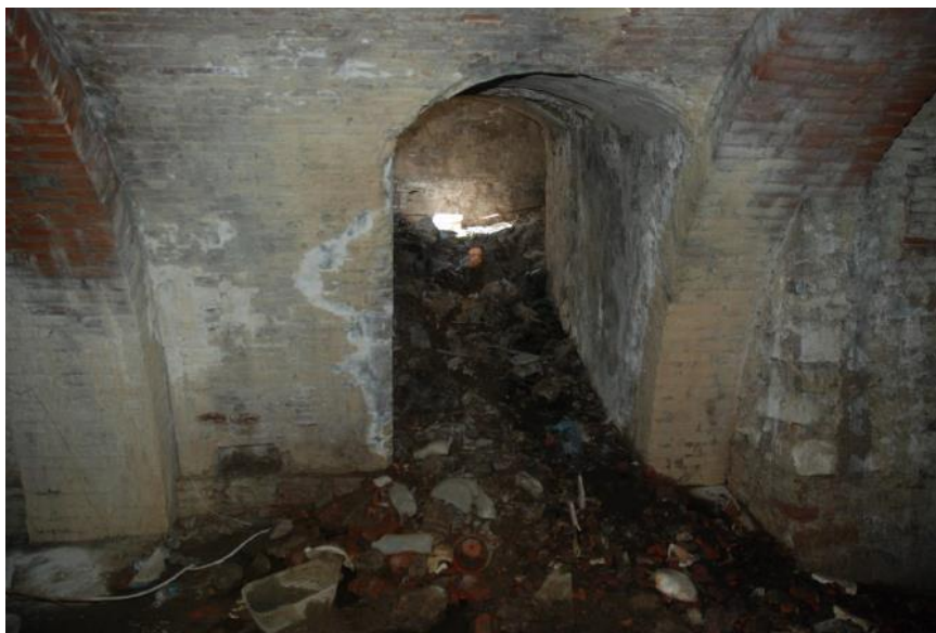
Foto attuale dell'interrato: scorcio 01
