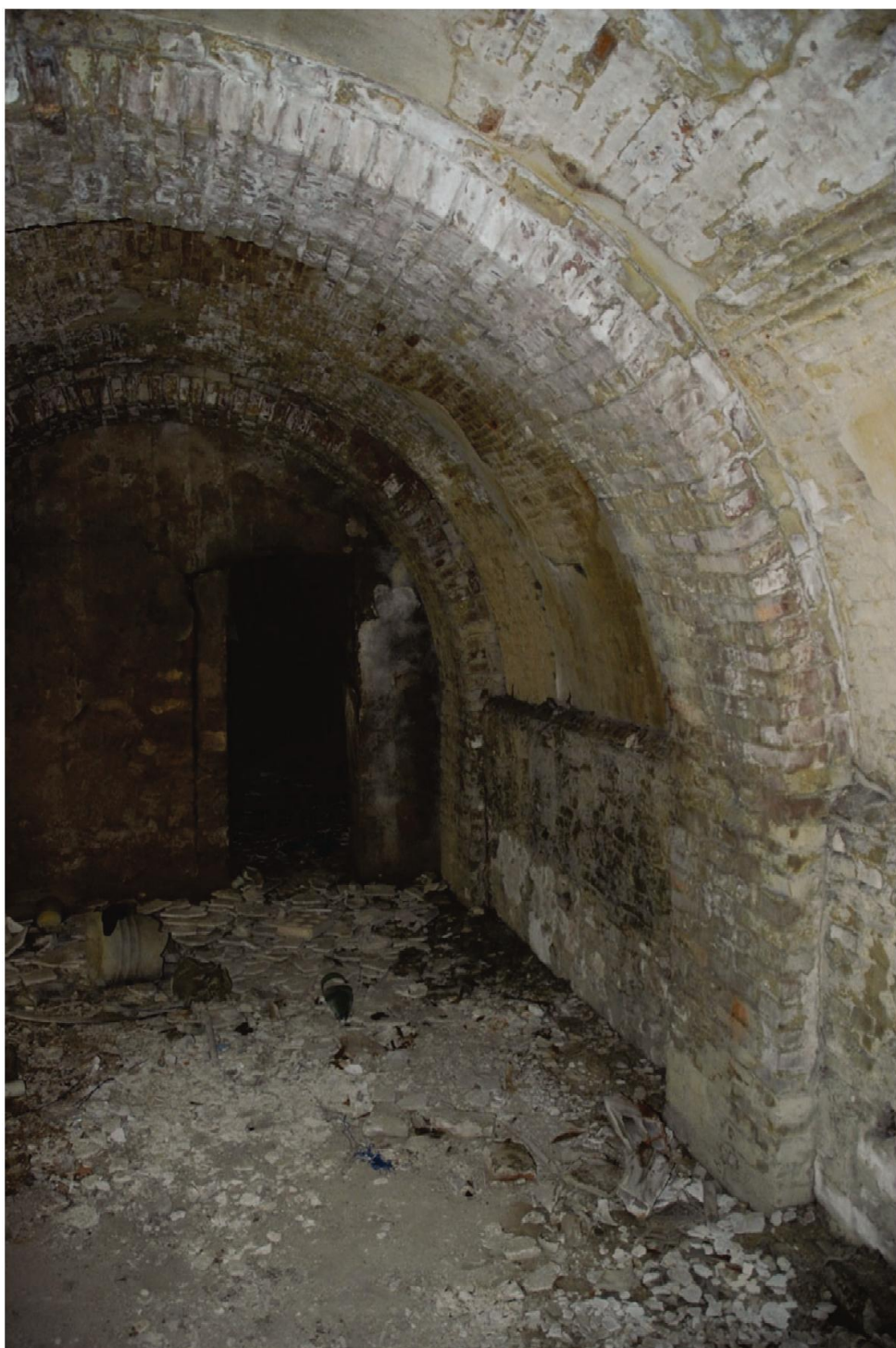
Foto 12 Foto attuale del Piano interrato: scorcio 02
