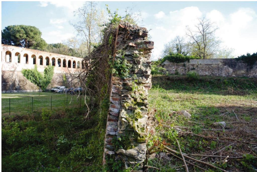
Foto 15 parte terminale del muro di contenimento del vallo
