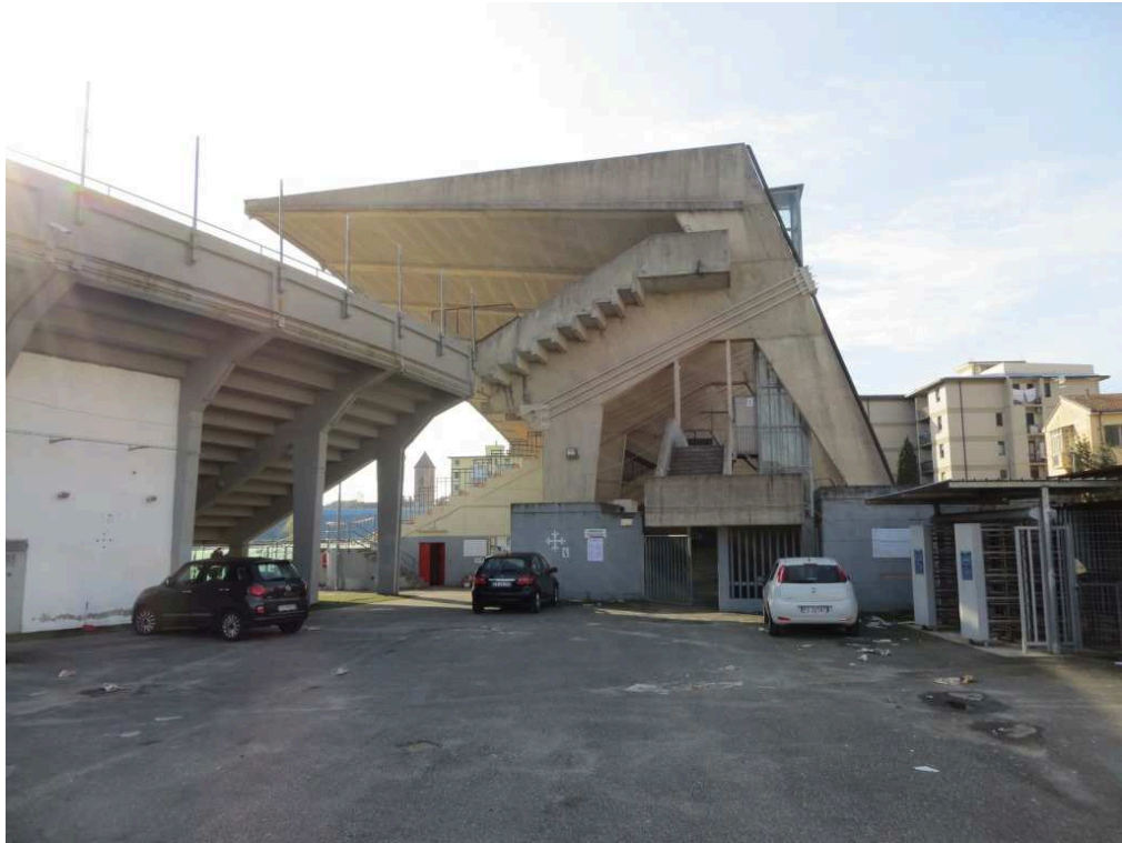
Vista laterale esterna della tribuna
