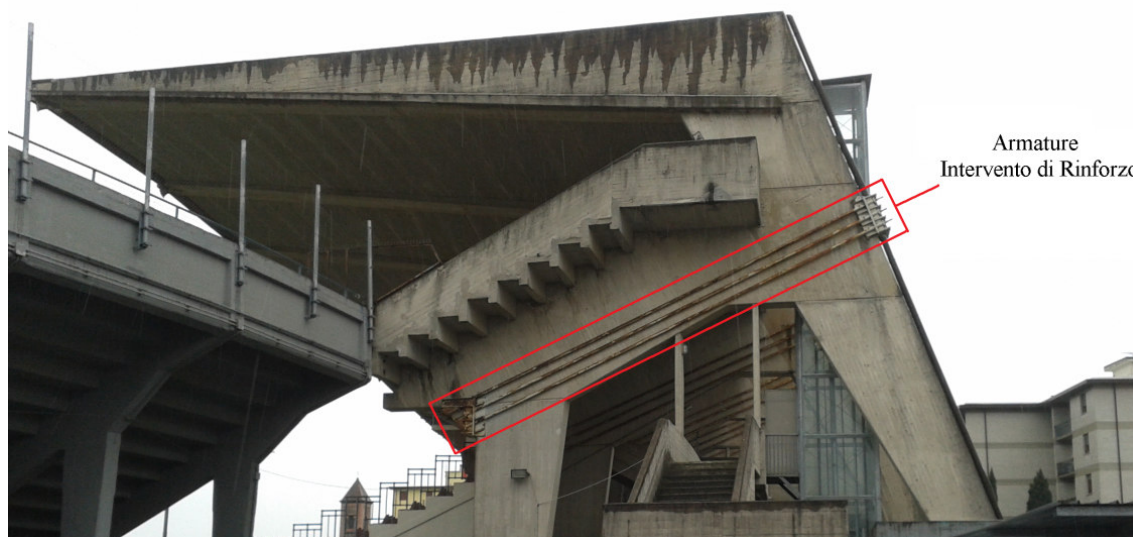
Figura 4.30 – Intervento di rinforzo tribuna coperta
