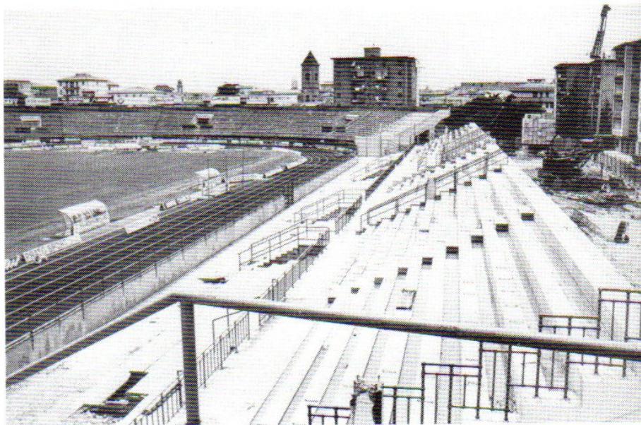
Figura 4.27 – Demolizione copertura vecchia tribuna (Luglio 1982)
