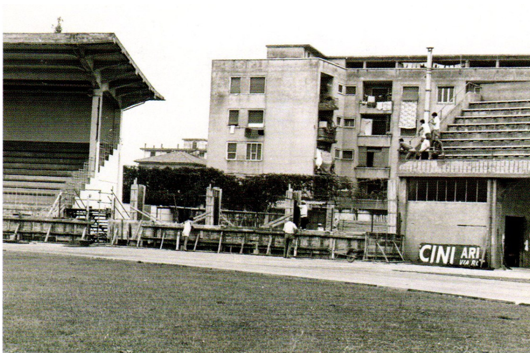
Figura 4.22 – Costruzione completamento Curva Nord
