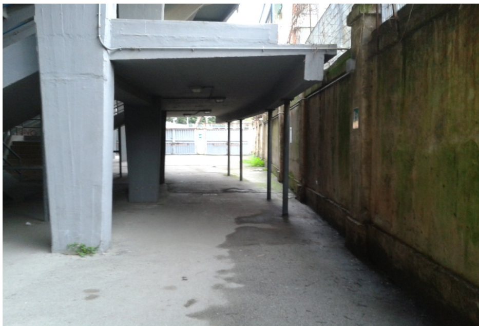
Figura 4.21 – Struttura ballatoio intermedio scale
