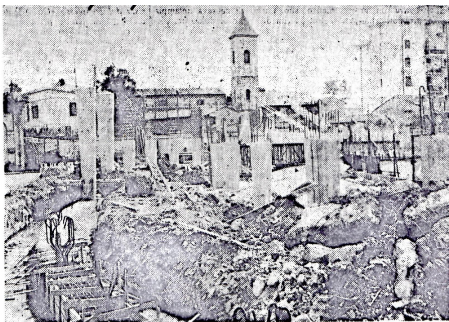
Figura 4.18 – Lavori di costruzione Curva Sud
