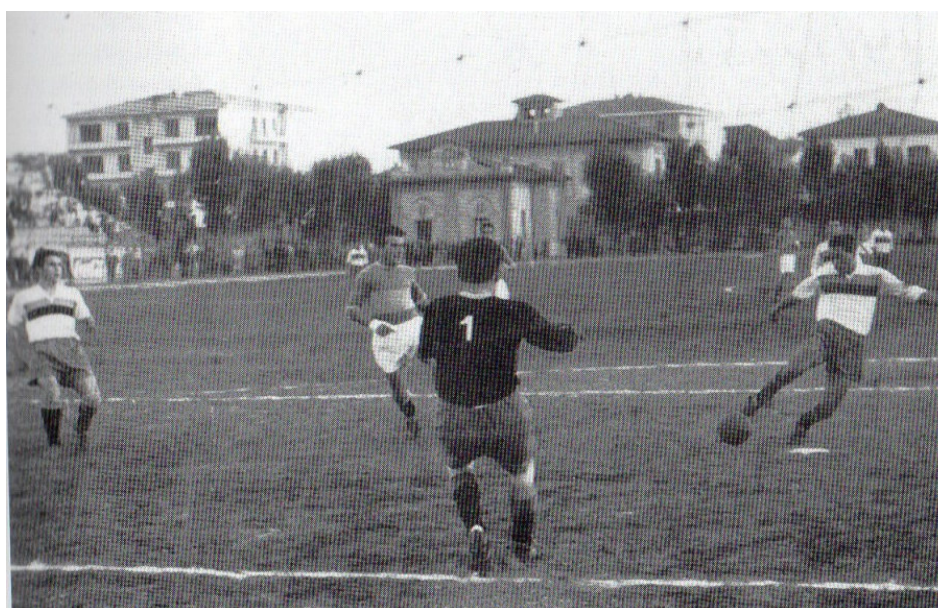
Figura 4.10 – Anni 50-60 lo stadio è ancora incompleto
