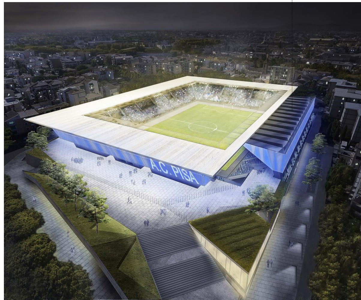
SOLUZIONE TETTO FOTOVOLTAICO Tetto fotovoltaico con tecnologia a film sottile
