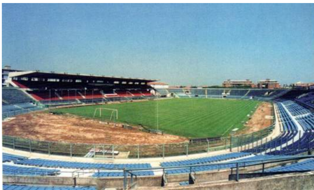
A fianco, Panoramica dell'Arena Garibaldi terminati i lavori di ampliamento
