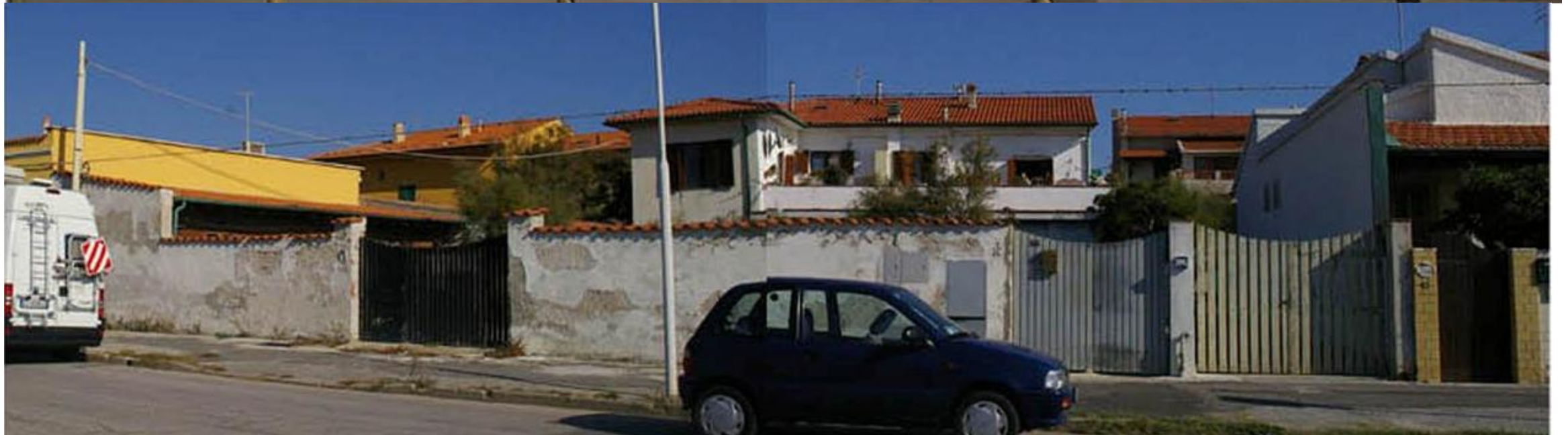
Particella 73 Cortili e pertinenze di fabbricati su via Maiorca
