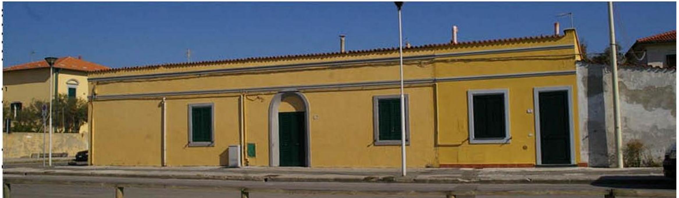
Particella 70 Fabbricato storico
