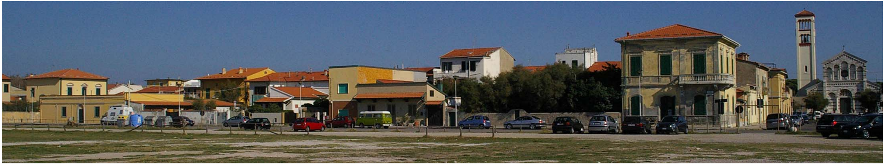
Lato est da via Ciurini a via Daiberto – Vista di insieme
