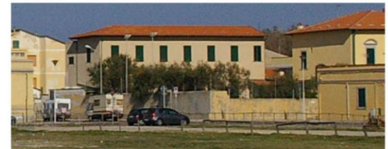
Particella 64- Restauro del muro perimetrale
