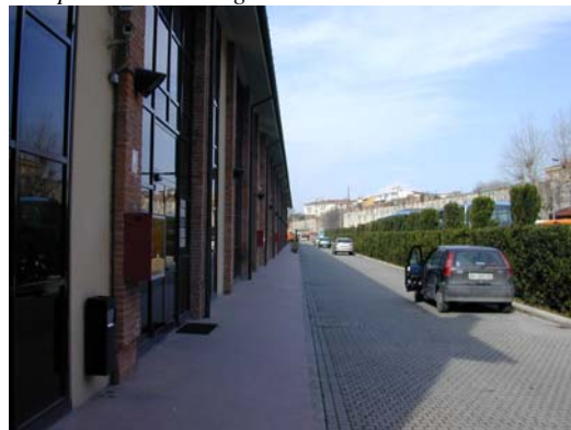
Prospetto interno lungo le mura urbane
